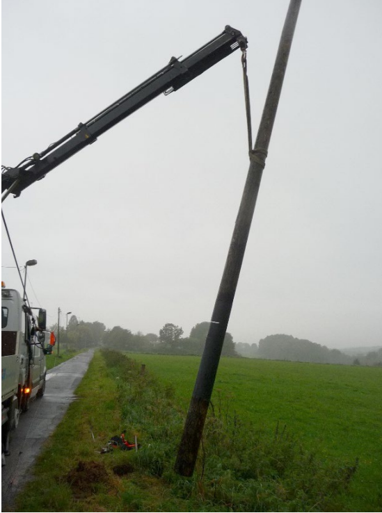
Abb. 33 Herausziehen eines Mastes mittels Kran
