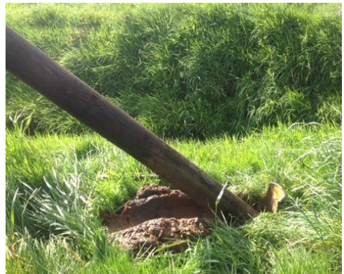
Abb. 14 Mastableiter zum Stellen von Holzmasten in Mastlöchern
