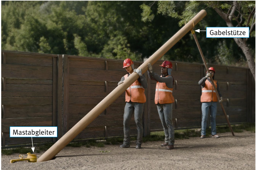
Abb. 13 Beispiel für ein manuelles Stellen eines TK-Holzmastes unter Verwendung eines Mastableiters und einer Gabelstütze
