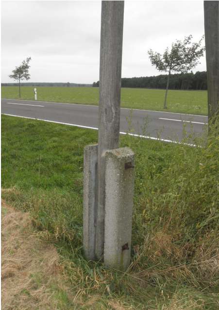
Abb. 36 Betonmastfußtyp IV als Doppelbetonmastfuß
