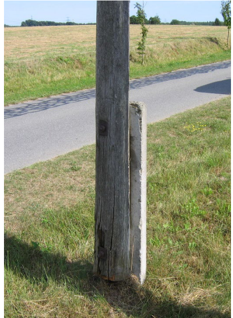
Abb. 37 Betonmastfußtyp IV als Einzelbetonmastfuß
