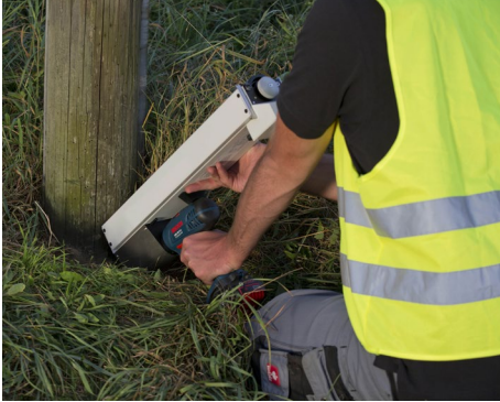
Abb. 19 Schrägbohrung unterhalb der Erdgleiche
