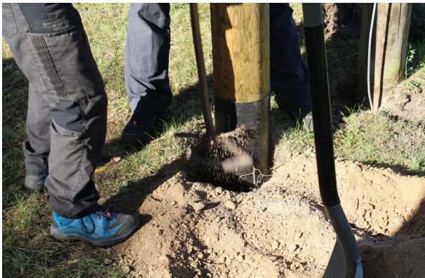
Abb. 15 Verdichten des Mastloch mittels Handstamper
