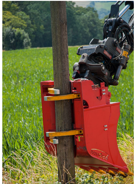
Abb. 26 Beim Einsatz hydraulischer Greifer kann auf Mastfußsicherungen verzichtet werden
