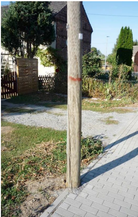
Abb. 24 Kennzeichnung eines aufgrund des Zustandes nicht ohne weitere Sicherungsmaßnahmen zu besteigenden und zum Austausch vorgesehenen Mastes
