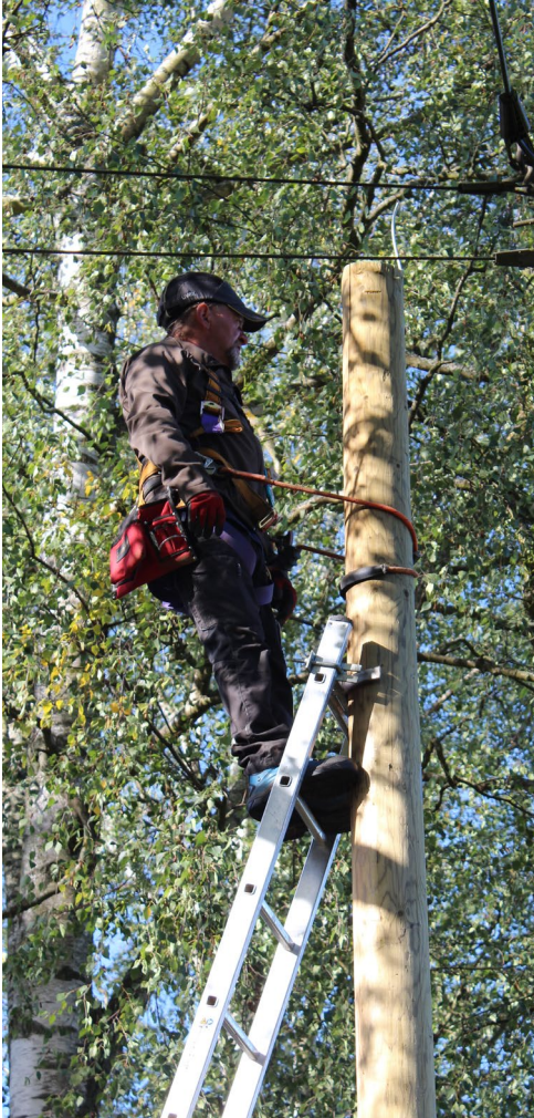
Abb. 29 Gesichertes Arbeiten auf Anlegeleitern an Holzmasten
