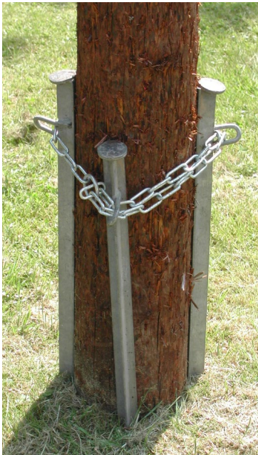
Abb. 25 Beispiel für eine Mastfußsicherung
