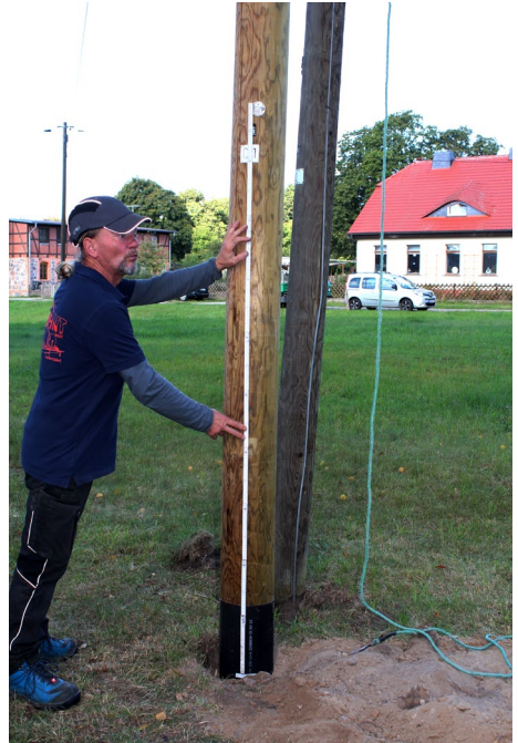
Abb. 6 Holzmaste mit beispielhafter Kennzeichnung der Einbautiefe
