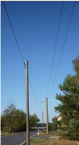
Abb. 31 Näherung TK-Linie mit Freileitung der EVU
