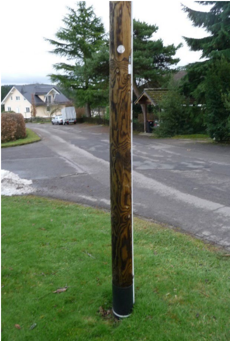
Abb. 6 Holzmaste mit beispielhafter Kennzeichnung der Einbautiefe
