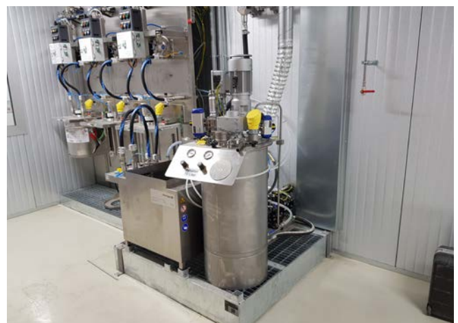
Abb. 29 Auffangwanne als Rückhalteeinrichtung
