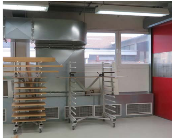
Abb. 45 Absaugung an Hordenwagen
