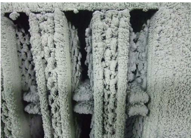
Abb. 44 Voll beladene Kartonfilter mit hoher Brandlast
