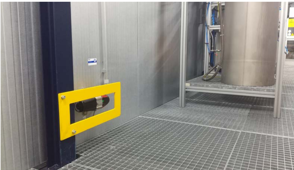
Abb. 27 Gaswarneinrichtung im Farbversorgungsraum (mit Anfahrerschutz)
