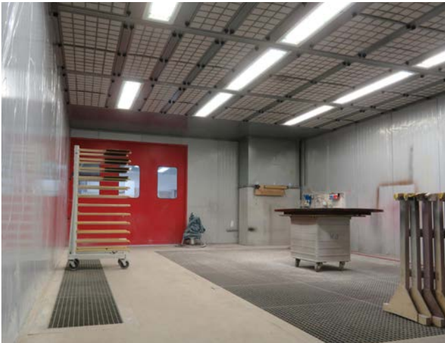
Abb. 38 Lackierraum, links Bodenabsaugkanal für frisch beschichtete Teile
