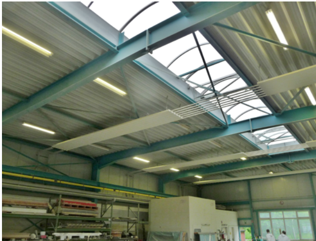
Abb. 17 Abgehängte Lichtbänder mit Tageslichtanteil
