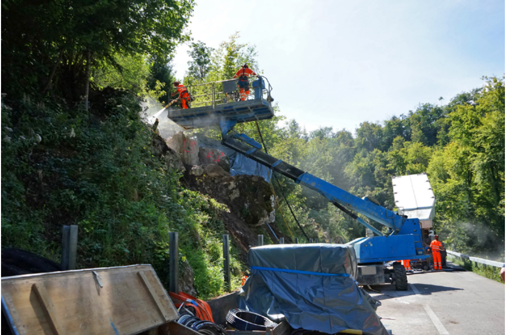
Abb. 1 Arbeiten mit einer fahrbaren Hubarbeitsbühne
