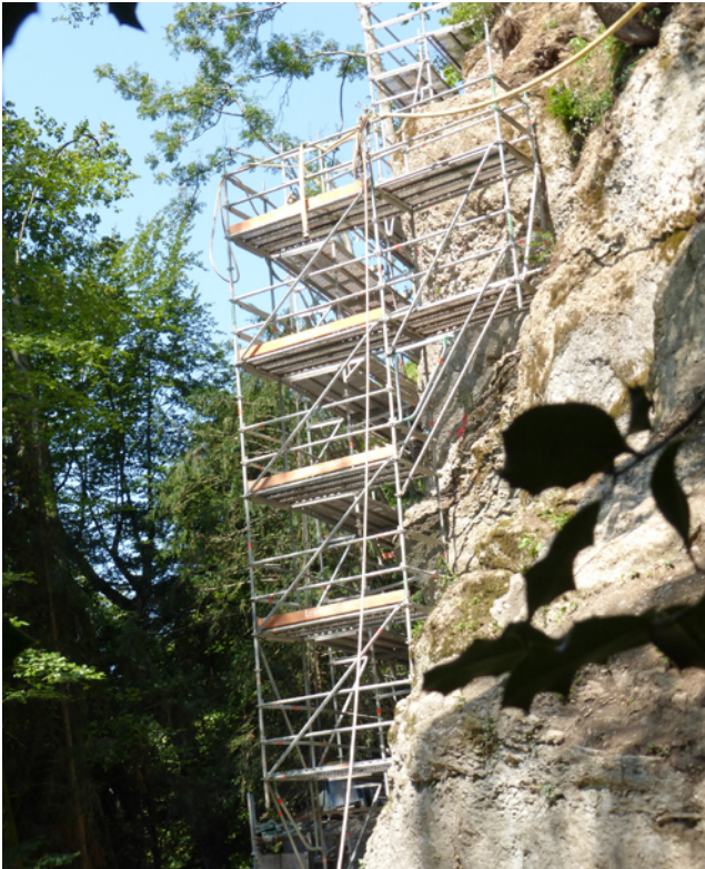
Abb. 22 Gerüst bei Hang- und Felssicherung
