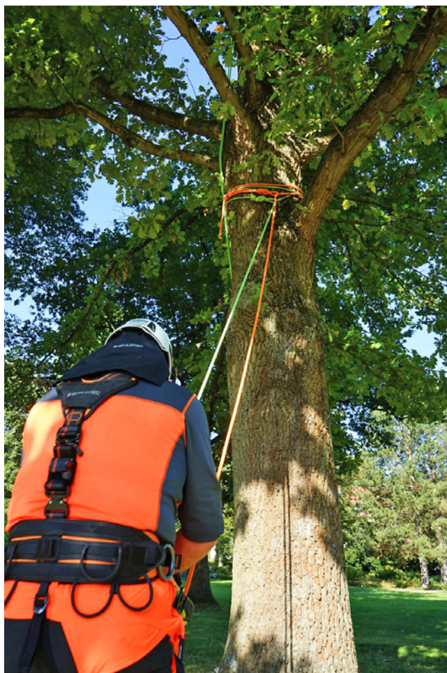
Abb. 18 Anschlagmöglichkeiten an einem Baum
