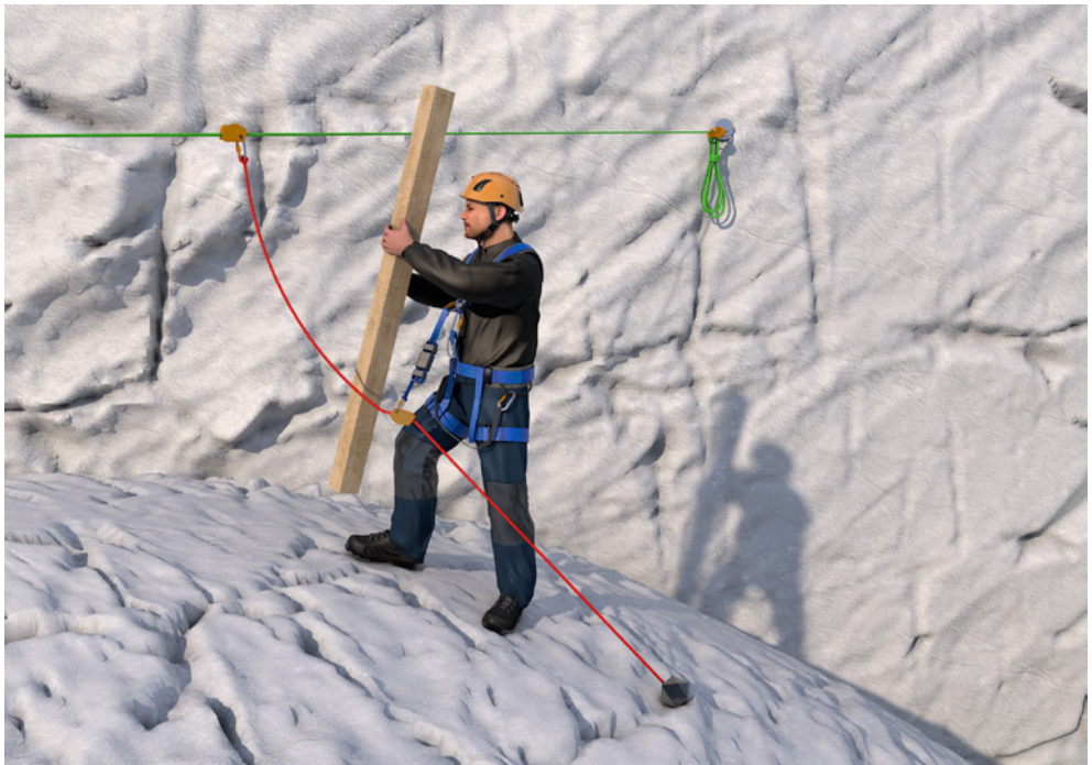
Abb. 4 PSA gegen Absturz (Auffangsystem): mitlaufendes Auffanggerät an beweglicher Führung
