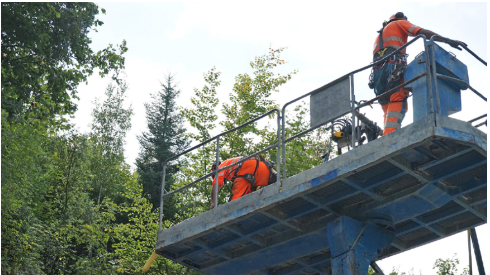
Abb. 24 Benutzung von PSA gegen Absturz in einer fahrbaren Hubarbeitsbühne
