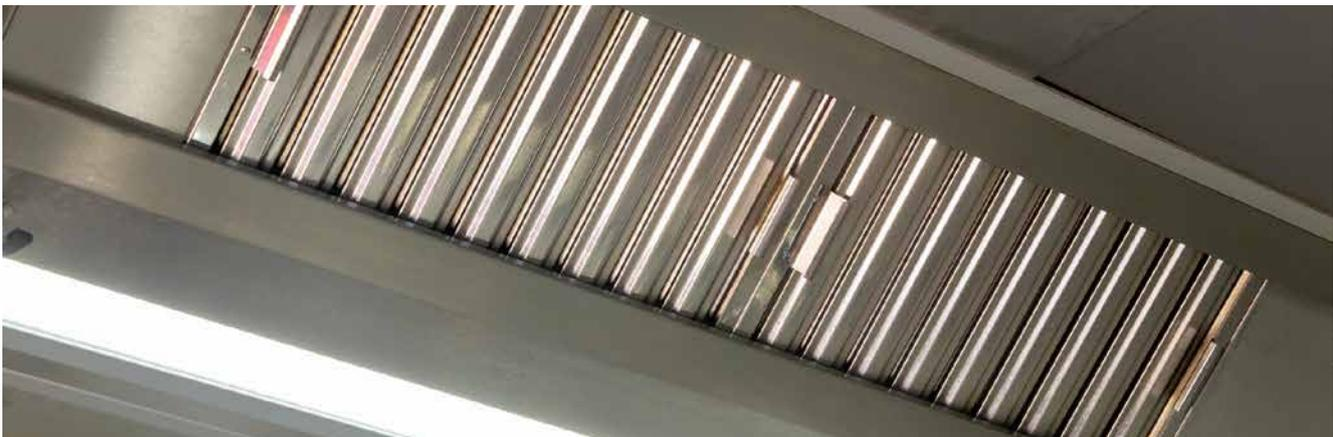
Abb. 7 Lüftungsanlage an einer Küchendecke
