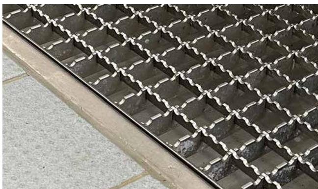
**Abb. 2** Rutschhemmender Gitterrost
