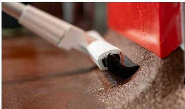
**Abb. 3** Erleichterte Reinigung durch Hohlkehlen
