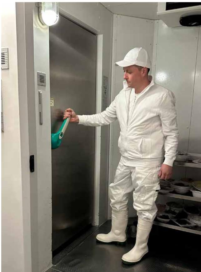
**Abb. 88** Entriegelung der Kühlraumtür von innen
