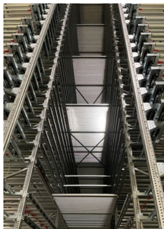
Abb. 23 Verlegte Gitterroste im Shuttlelager
