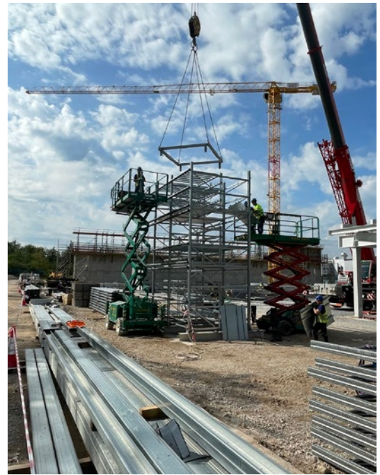
Abb. 7 Vormontage Block stehend
