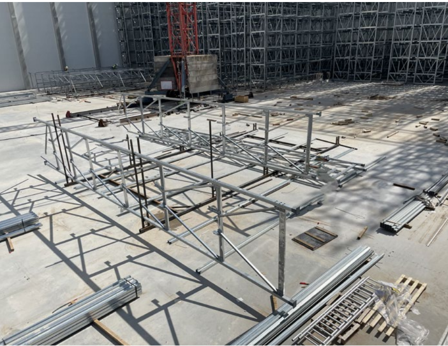
Abb. 6 Vormontage Block liegend
