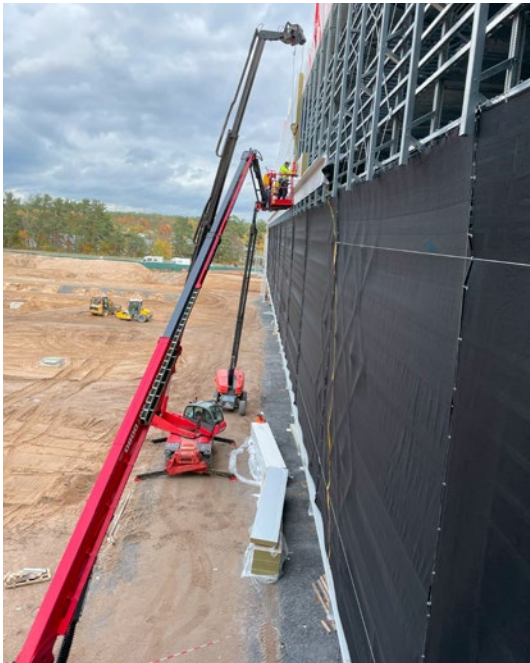
Abb. 12 Fassade montieren mit Hubarbeitsbühnen
