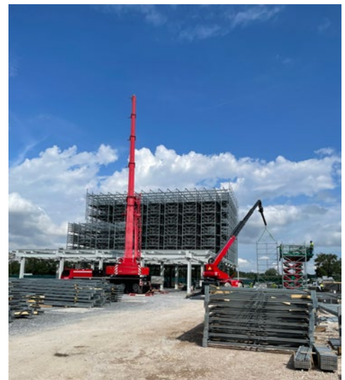
Abb. 40 Teleskopstapler Regalmontage
