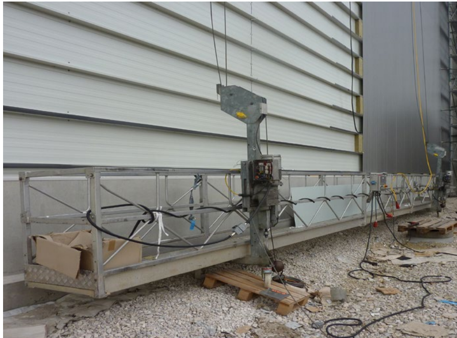
Abb. 13 Fassade montieren mit hängender Arbeitsbühne
