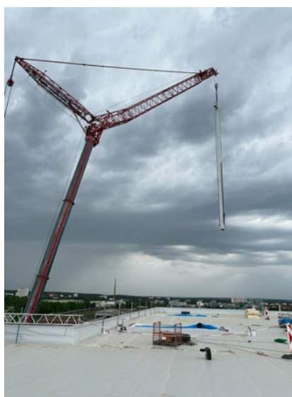
Abb. 17 Montage RBG über Dach
