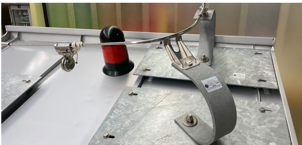
Abb. 10 Beispiele Anschlag-einrichtungen für Dacharbeiten
