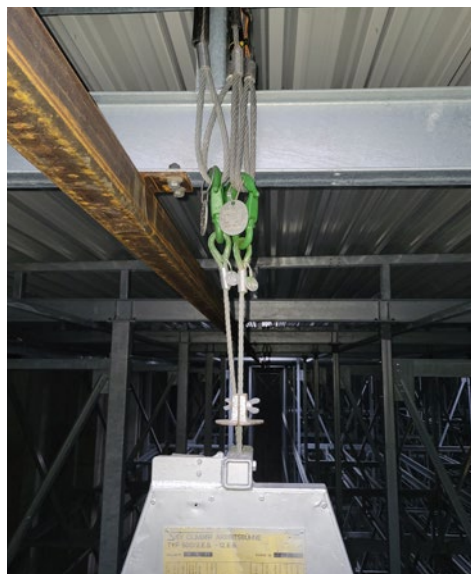
Abb. 29 Befestigung mit Stahlseilschlingen mit Kantenschutz
