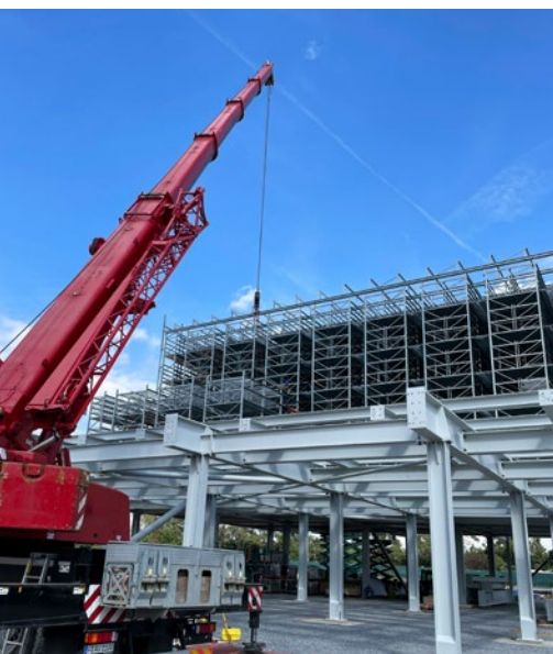
Abb. 37 Fahrzeugkran im Einsatz
