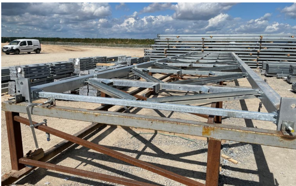
Abb. 5 Vormontage Rahmensegment
