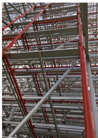
Abb. 14 Verlegte Sprinklerrohre
