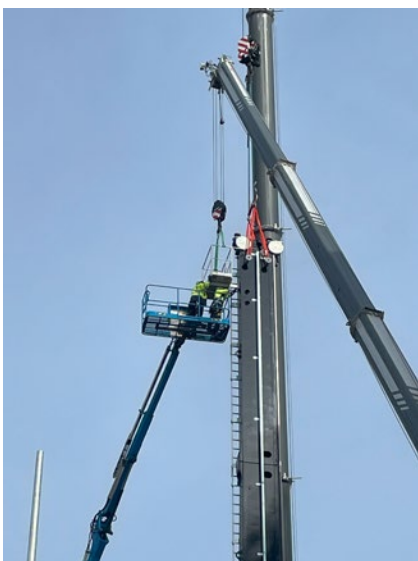
Abb. 16 Montage des Kopftraversenpodests
