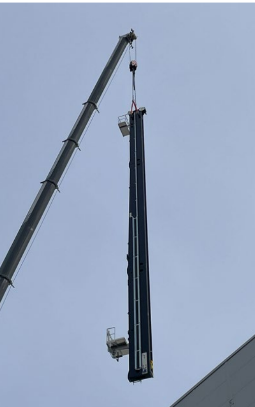
Abb. 21 Einheben des komplettierten Mastes über Dach
