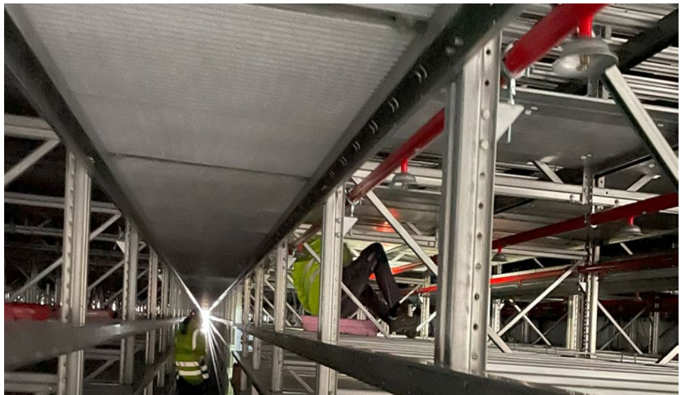
Abb. 15 Sprinklerrohrmontage Shuttlelager
