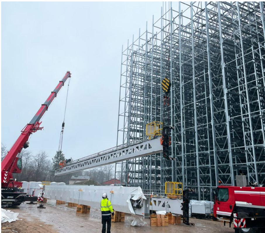
Abb. 19 Abladen RBG mit 2 Kranen
