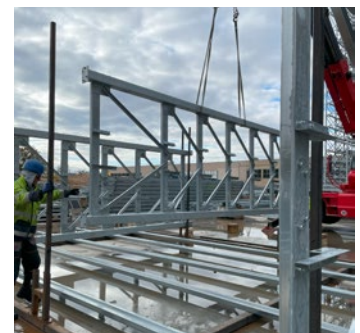
Abb. 42 Ketten und Hebebänder im Einsatz
