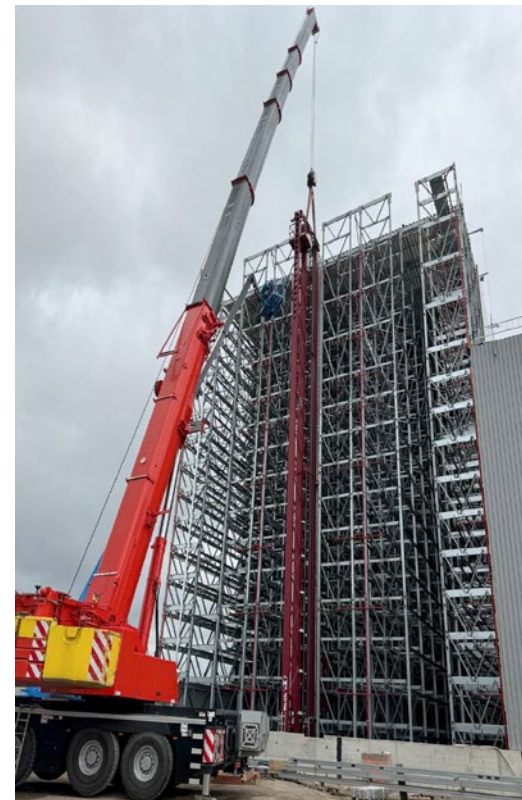
Abb. 20 Einführen RBG in Regalgasse
