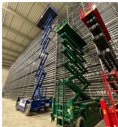
Abb. 27 Scherenbühneneinsatz im Shuttlelager
