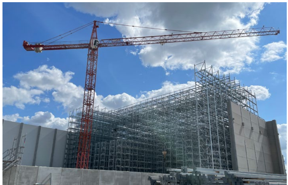
Abb. 38 Turmdrehkran im Einsatz
