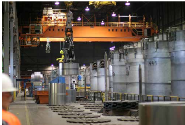
Abb. 27 Krantransport in der Haubenglüherei
