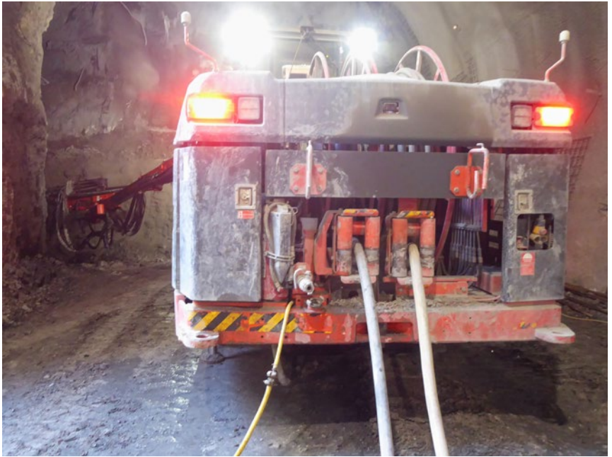
Abb. 4 Leitungslänge wird vom Bohrwagen abgetrommelt
