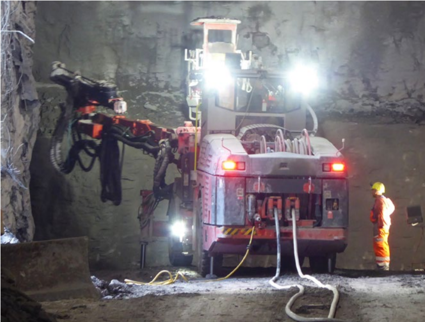
Abb. 2 Bohrgerät im Vortrieb
