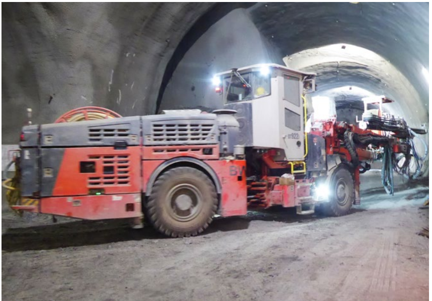
Abb. 1 Bohrgerät auf der Zufahrt
