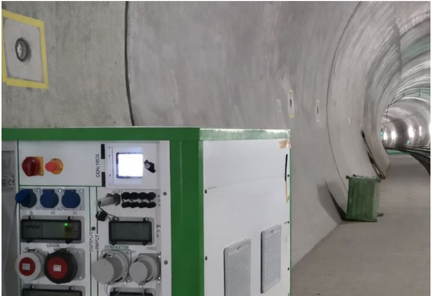
Abb. 12 Akkubasierter Hybridspeicher als Pufferlösung für Lastspitzen
