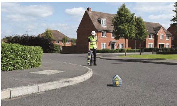
Abb. 8 Aktive Ortung, im Vordergrund Sender zur Signaleinkopplung
