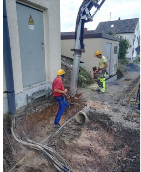
Abb. 4 Saugrohr eines Saugbaggers im Einsatz
