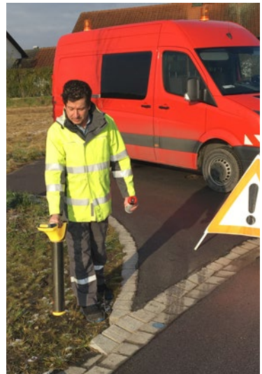
Abb. 5 Leitungssuche mit Ortungsgerät
