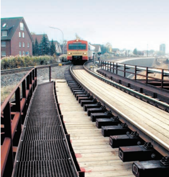
Abbildung 3: An Engstellen – zum Beispiel auf Brücken – muss mindestens auf einer Seite ein durchgehend begehbare Sicherheitsraum vorhanden sein.
