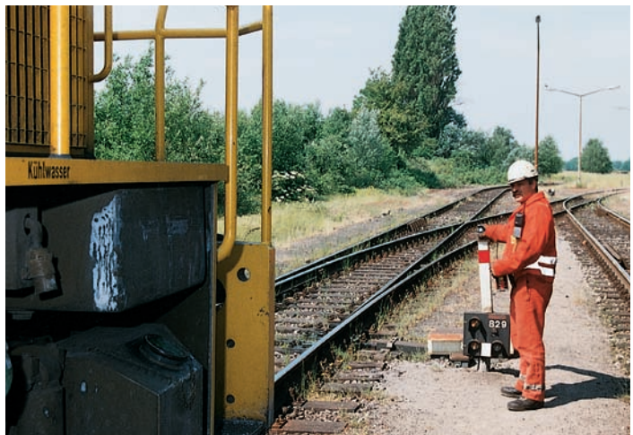
Abbildung 14: Weichen- und Zwergsignale können bei geringer Höhe in den für den Sicherheitsabstand erforderlichen Raum hineinragen.
