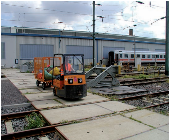
Abbildung 13: Für Verkehrswege und Gleisübergänge die von Flurförderzeugen befahren werden, ist Ebenheit und gute Übersichtlichkeit besonders wichtig.
