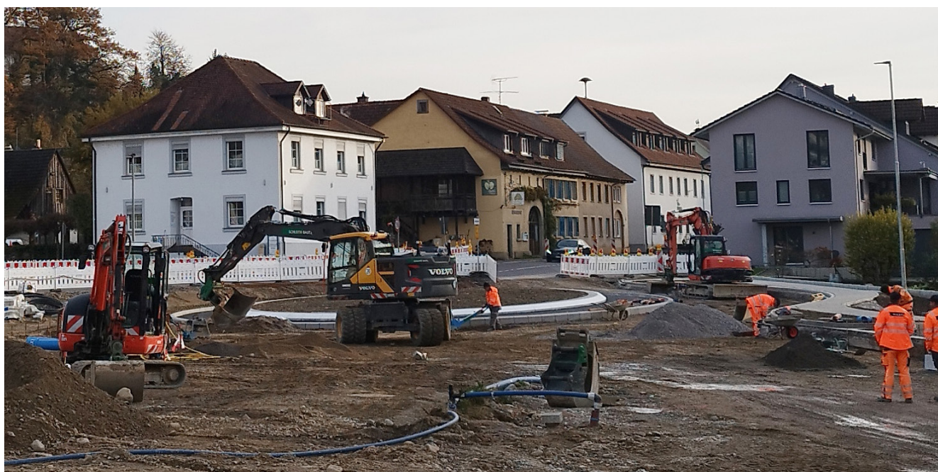
Abbildung 1: Mobilbagger auf Tiefbaustelle
