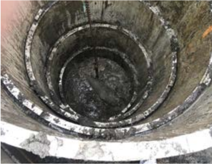
Abb. 13 Sicherung der Grabenwände mit nichtferromagne- tischen Verbau
