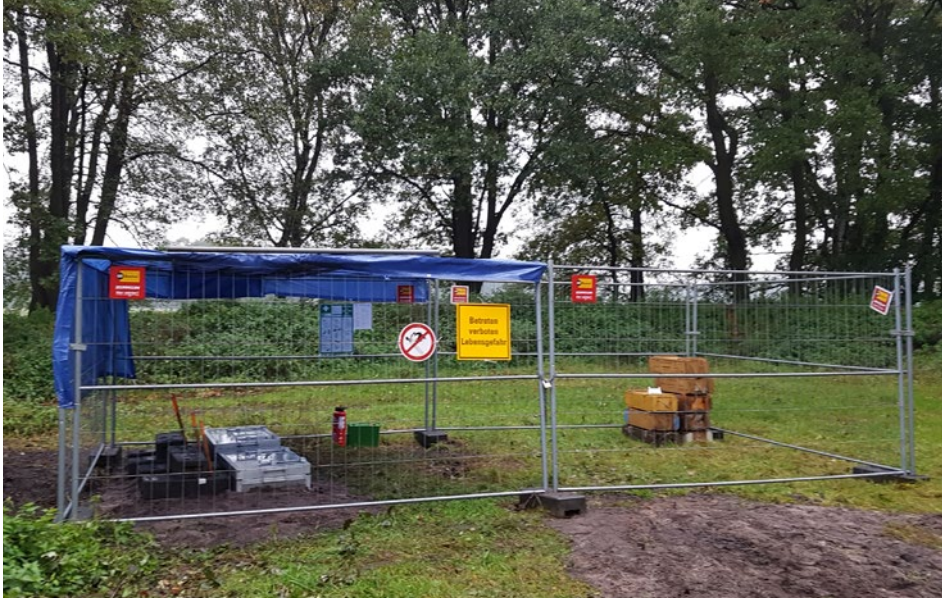
Abb. 15 Aufbewahren/Bereitstellen von Kampfmitteln
