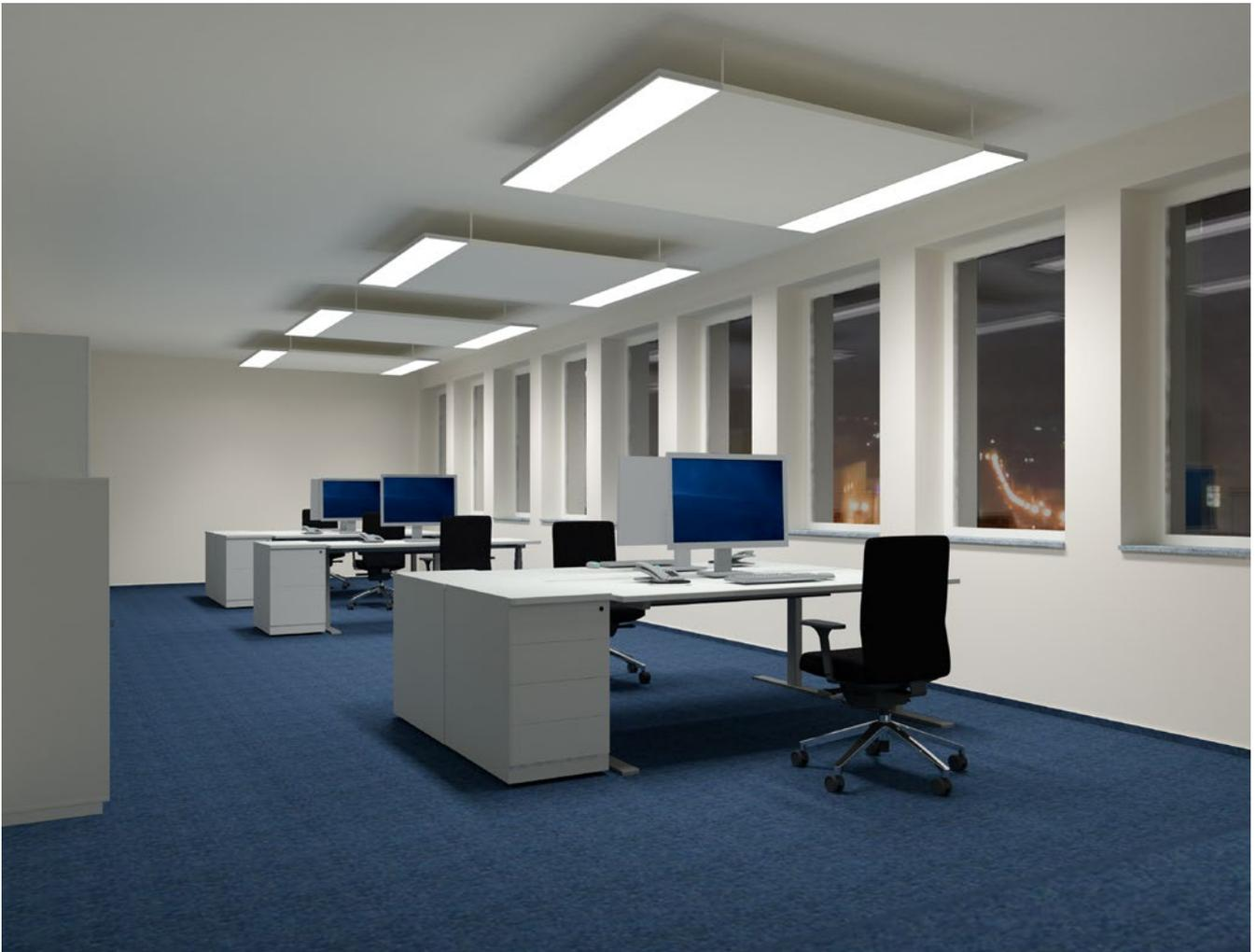
Über den gesamten Arbeitsbereich sind Akustiksegel abgehängt. Die parallel zu den Fenstern ausgerichteten Flächenleuchten sind in diesen Segeln integriert und bilden mit ihnen eine Montageeinheit. Der Bereich, in dem die Arbeitsplätze angeordnet sind, wird somit gleichmäßig von den direktstrahlenden Flächenleuchten ausgeleuchtet.
