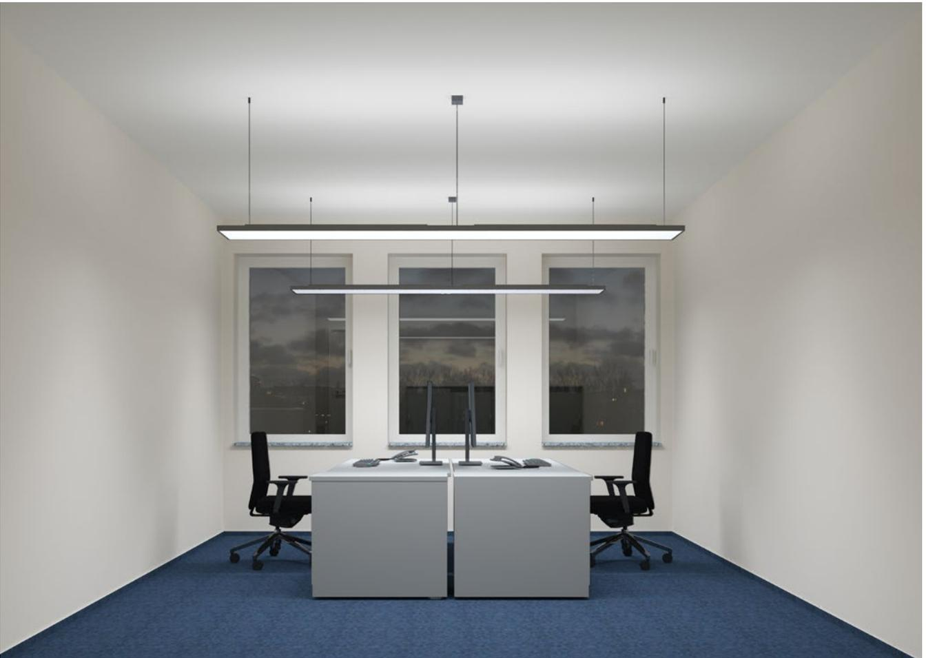
Die beiden parallel zum Fenster angeordneten direkt/indirekt strahlenden abgependelten Leuchtenbänder sorgen für eine Ausleuchtung des gesamten Raums (raumbegrenzende Beleuchtung) und eine angenehm gleichmäßige Aufhellung der Wände und der Decke. Ihre Anordnung orientiert sich an der Blockaufstellung der Arbeitsplätze.
