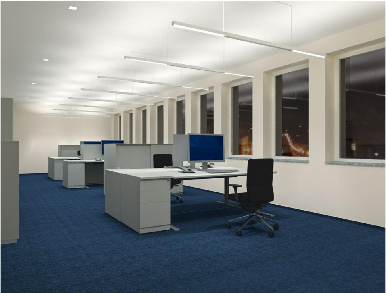
Jeweils zwischen zwei Achsen und senkrecht zur Fassade sind direkt/indirekt strahlende Pendelleuchten abgehängt. Damit wird eine gleichmäßige Ausleuchtung des Bereichs erzielt, in dem die Arbeitsplätze an der Fensterfront entlang positioniert sind. Die Pendelleuchten strahlen direkt auf die Arbeitsfläche, wobei der Mittelteil der Leuchte abgedeckt ist. Damit werden mögliche Reflexblendungen vermieden.
