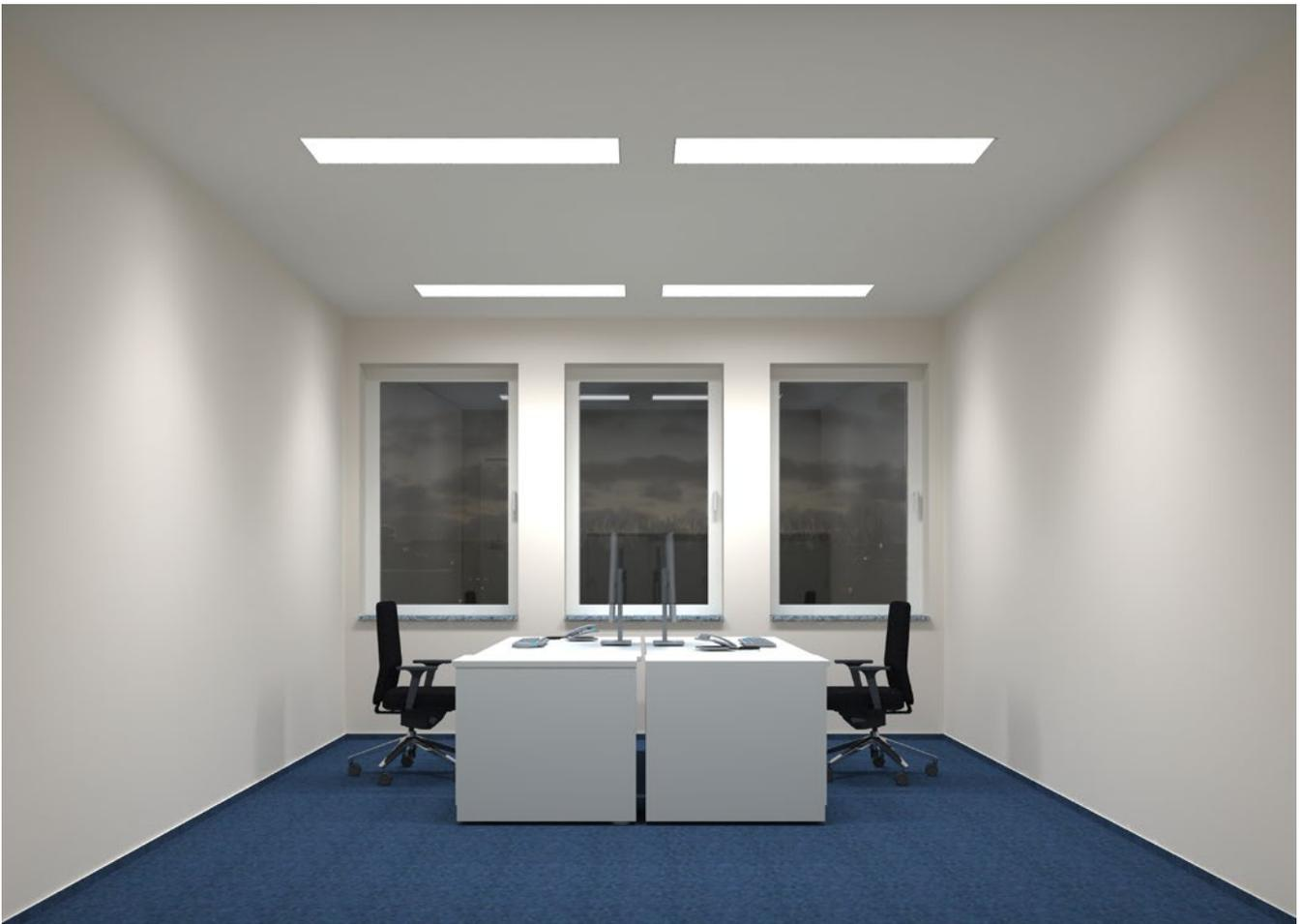
Die 4 in die Decke eingebauten Flächenleuchten sind so angeordnet, dass ein ausreichend großer Abstand zu den Wänden vorhanden ist. So können auffällige bogenförmige Helligkeitsmuster an den Wänden vermieden werden. Die Decke bleibt bei der ausschließlich direkten
