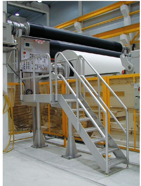
Abb. 15 Zum Arbeitspodest am Poperoller führt eine normgerechte Treppe.
