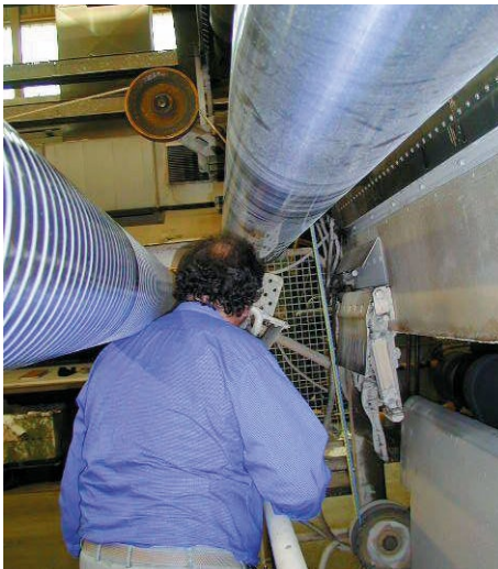
Abb. 8 Ganz offensichtlich ist zwischen den beiden Walzen der erforderliche Sicherheitsabstand von 500 mm nicht eingehalten. Die Einlaufstelle muss gesichert werden z. B. durch Verwehren des Zugangs in den Gefahrenbereich.
