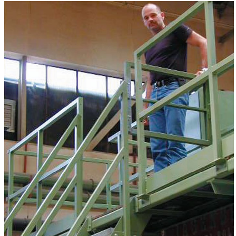
Abb. 16 Ein selbstschließender Türbügel sichert die Geländerunterbrechung, die durch den Anschluss der Maschinentreppe entsteht.
