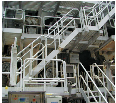
Abb. 13 Die Arbeitsplätze an der Papiermaschine sind über ein System von Treppen und Laufstegen gut erreichbar.
