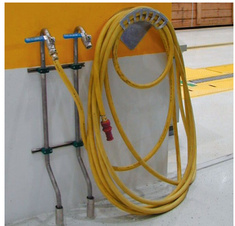
Abb. 19 Von einem aufgehängten Schlauch geht keine Stolpergefahr aus.
