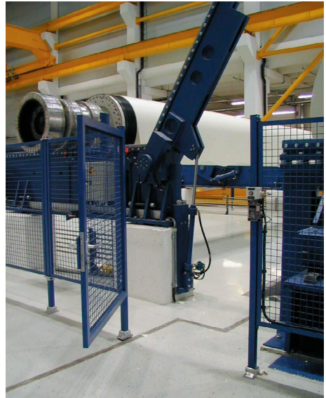
Abb. 2 Der Zugang in den Gefahrenbereich erfolgt durch eine verriegelte Tür mit Zuhaltung.
