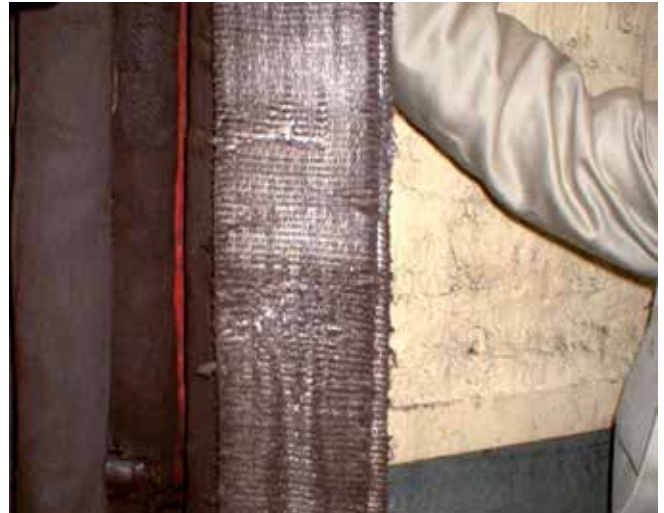
Bild 3-2: Prüfung durch einen Sachkundigen, Beispiel 2
