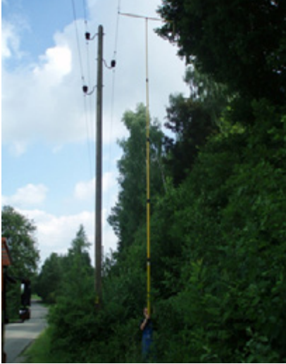
Abb. 4 Abstandsermittlung vom Boden aus
