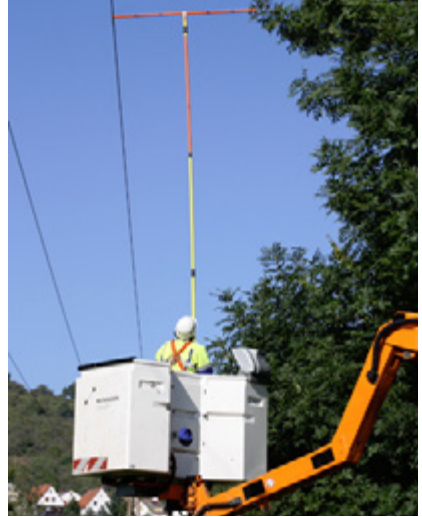
Abb. 5 Abstandsermittlung vom Korb der Hubarbeitsbühne aus
