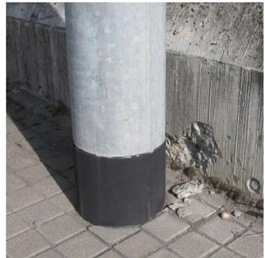
Abb. 5 Betonschaden durch Blitzentladung
