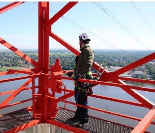
Abb. 4 Freileitungsmast mit Bühnen und mehrteiligem Seitenschutz.
