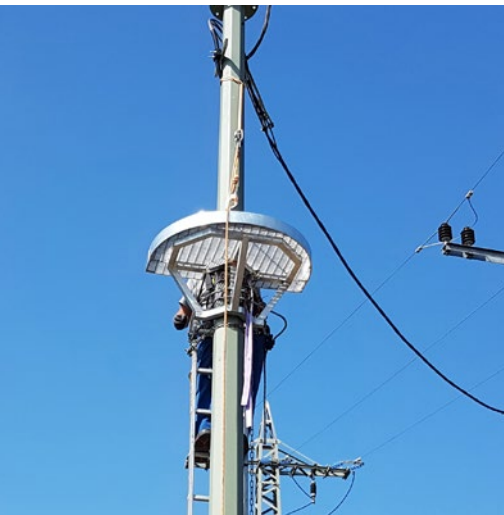
Abb. 88 Beispiel für eine Maststeigleiter ohne feste Führung.
