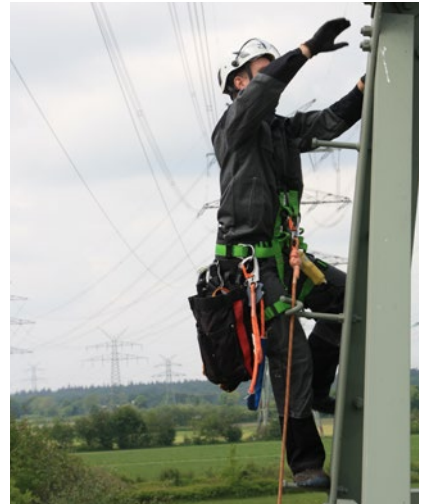
Abb. 72 Beispiel für einen Steigbolzen-gang. Um die Absturzhöhe möglichst gering zu halten, ist hier jeder vierte Steigbolzen mit einer Sicherheitseinrichtung ausgeführt.
