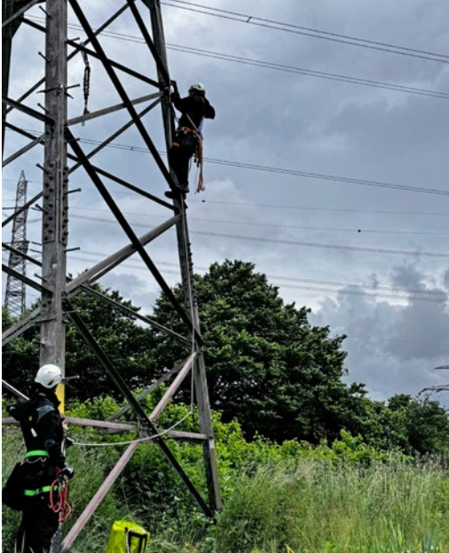
Abb. 69 Der erste aufsteigende Versicherte installiert mit Bandschlingen und Karabinerhaken Anschlagpunkte und hängt die bewegliche Führung (Sicherungsseil) in diese ein. Während des gesamten Aufstiegs ist er an einer Auffangöse seines Auffanggurtes am Sicherungsseil gesichert. Der Versicherte am Boden führt die erforderliche Seillänge nach. Im Absturzfall blockiert die Seilbremse das nachlaufende Sicherungsseil. Ein Retten ist durch weiteres Nachlassen des Sicherungsseils unmittelbar möglich, sofern die Seilbremse nach Angaben des Herstellers in der Gebrauchsanleitung hierfür zugelassen ist.
