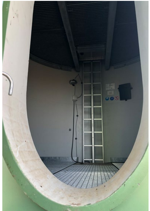
Abb. 3 Freileitungen des Typs Compact-Line bieten mit ihrer Bauweise als Stahlvollwandmaste die Möglichkeit zum Besteigen im Inneren der Maste.
