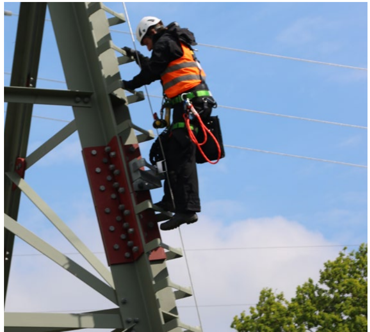
Abb. 11 Beispiel für einen Steigbügelgang mit einer festen Führung (gespanntes Stahlseil).
