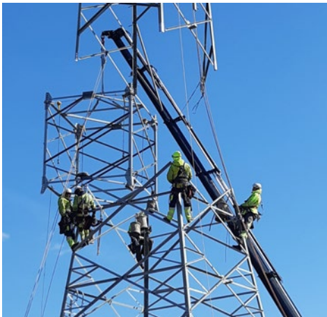
Abb. 163 Beispiel für eine Montagesituation beim Aufsetzen eines Mastschusses im Rahmen einer Masterrhöhung.
