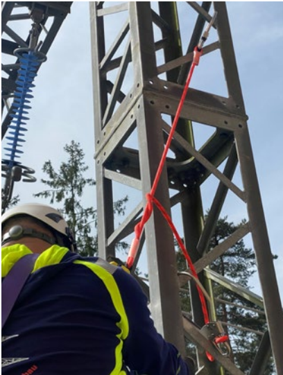
Abb. 62 Beispiel für den Einsatz eines Y-Seils gemäß Abb. 41 beim Besteigen eines Notgestänges. Beim wechselseitigen Anschlagen kann es zu einem Verdrehen der Verbindungsmittel kommen.
