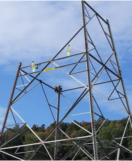
Abb. 164 Beispiel für eine Montagesituation bei der Errichtung einer Mastseitenwand.
