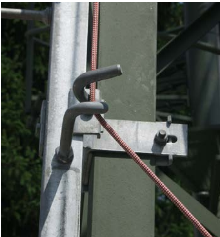
Abb. 45 Beispiel für einen Steigbolzen mit Sicherheitseinrichtung mit eingefädeltm Sicherungsseil
