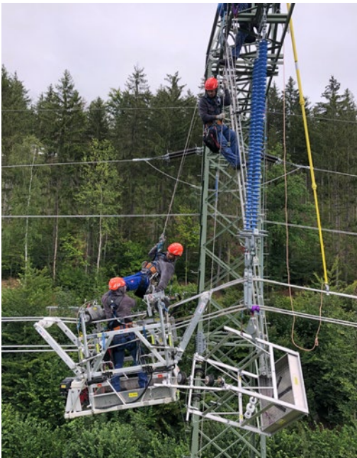
Abb. 138 Beispiel für die Rettung einer verletzten Person durch die Verwendung von PSA zum Retten.
