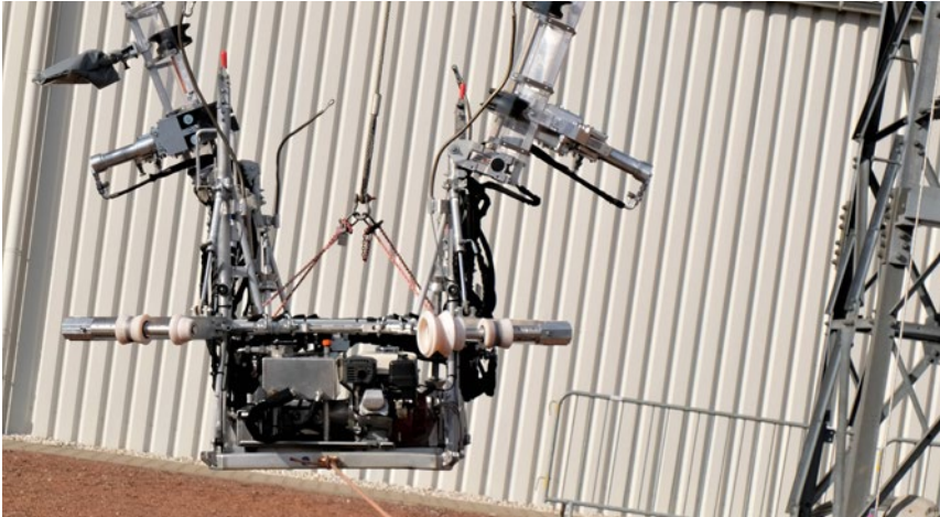
Abb. 122 Beispiel für das Hochziehen eines Leitungsfahrzeuges zum Leiterbündel im Hebezeugbetrieb.
