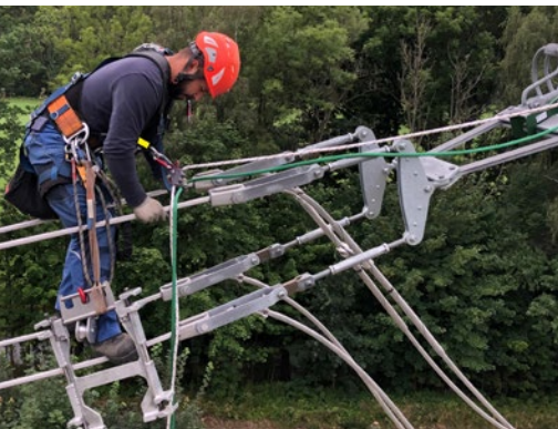
Abb. 126 Beispiel für den Zugang zu der Arbeitsposition zur Montage eines Aufzugrahmens.
