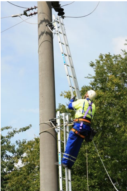
Abb. 86 Maststeigleitern mit integrierter fester Führung DIN EN 353-1 ermöglichen den Aufbau des Zugangswegs unter gleichzeitiger Sicherung gegen Absturz. Während der Montagearbeiten der Leiterelemente ist eine zusätzliche Positionierung des Versicherten mit einem Halteseil erforderlich.
