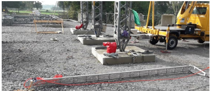
Abb. 107 Ausführung der Anschlagereinrichtung mit Zwischenanschlag, der über eine Fußraste entriegelt werden kann.
