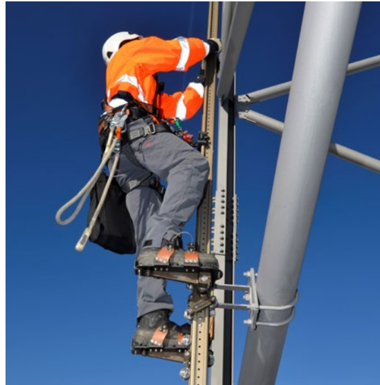
Abb. 17 Benutzung einer Steigschiene unter Verwendung von Steigschuhen und eines mitlaufenden Auffanggeräts zum Schutz gegen Absturz.
