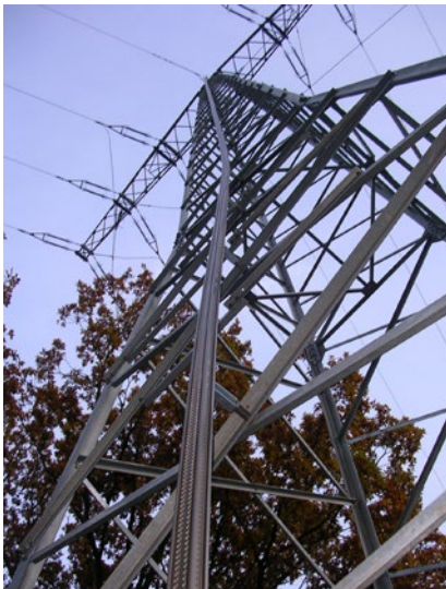
Abb. 14 Beispiel für eine Steigschiene die mit zugehörigen Steigschuhen benutzt wird. Die Schiene dient gleichzeitig als Steigschutzeinrichtung und kann alternativ auch mit einer elektromotorisch betriebenen Befahrenrichtung benutzt werden.
