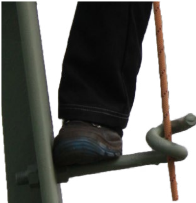
Abb. 18 Beispiel für die konstruktive Ausführung eines Steigbolzens mit Sicherheitseinrichtung. Das gewendelte Ende gewährleistet einen Schutz gegen Abrutschen und ermöglicht das Einfädeln eines Sicherungsseils.
