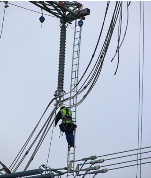
Abb. 113 Durchführung von Arbeiten auf einer Hängeleiter. Der Versicherte ist durch ein Höhensicherungsgerät gegen Absturz gesichert. Durch den zweisträngigen Einsatz seines Halteseils hat sich der Versicherte in seiner Arbeitshaltung positioniert und kann beide Hände zur Durchführung der Montagearbeiten benutzen.
