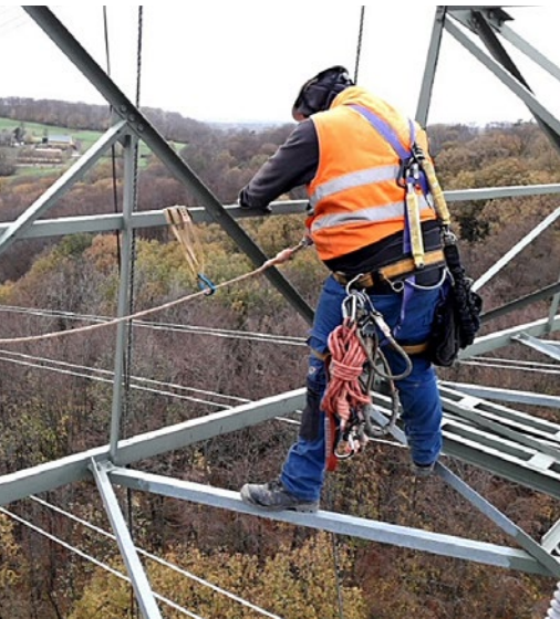
Abb. 100 Begehen einer Traverse unter Anwendung der Schlaufenmethode.
