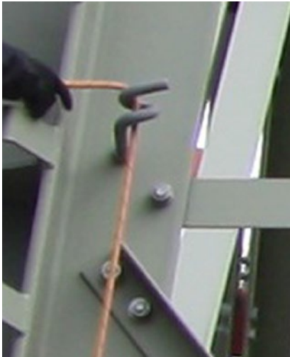
Abb. 71 Beispiel für einen Steigbolzen mit Sicherheitseinrichtung mit eingefädelttem Sicherungsseil.
