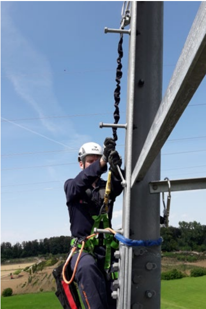
Abb. 33 Der Versicherte ist durch einen Auffanggurt in der Auffangfunktion gesichert. Mit einem Halteseil positioniert er sich an der Arbeitsstelle.
