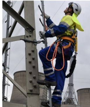
Abb. 8 Beispiel für eine Steigleiter mit Steigschutz-einrichtung als feste Führung.
