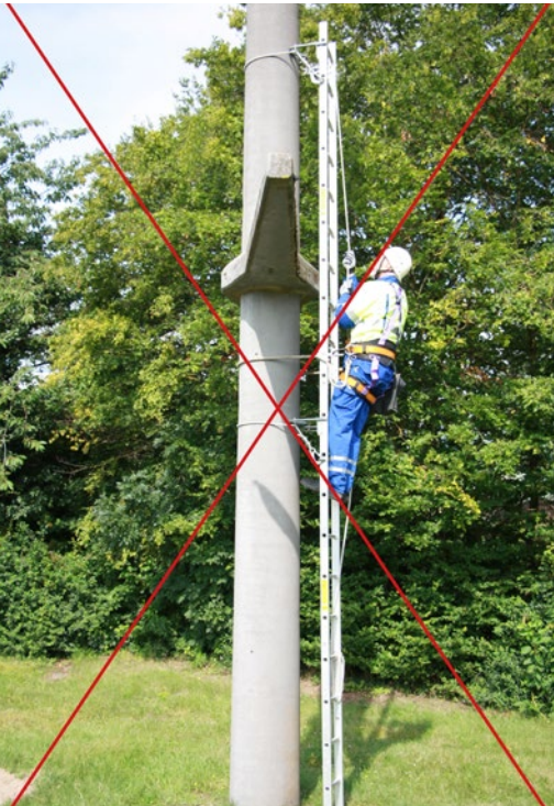
Abb. 88 Beispiel für eine Maststeigleiter ohne feste Führung.
