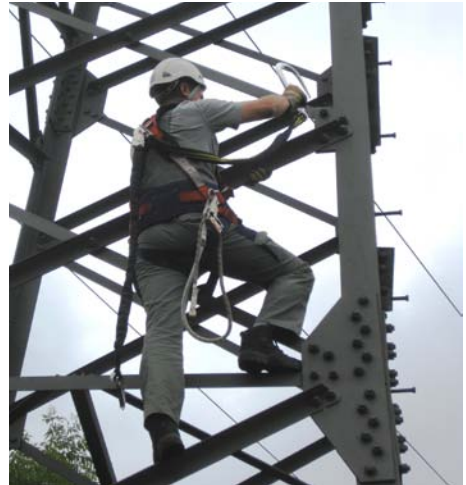
Abb. 39 Beispiel für den Einsatz zweier Verbindungsmittel gemäß Abb. 29 mit integrierter Falldämpfungsfunktion.
