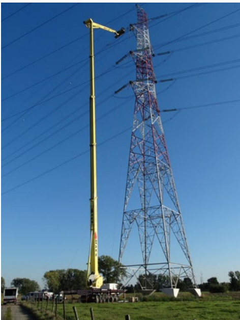
Abb. 6 Einsatz einer Hubarbeitsbühne für Arbeiten an einer Stromschleufe .
