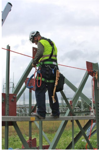
Abb. 153 Beispiel für einen temporär installierten Gehbalken und eine horizontale Anschlageneinrichtung bei der Vormontage eines Mastschusses. Die Anwendung erfordert konstruktive Vorkehrungen zur Montage der Ausrüstungen bei der Vormontage im liegenden Zustand des Mastschusses.
