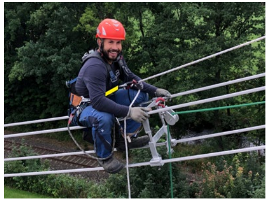
Abb. 127 Beispiel für einen auf dem Leiterbündel montierten Aufzugrahmen. Das Tragmittel zum Hochziehen des Leitungsfahrzeuges verläuft von der Traverse über eine Umlenkrolle zum Boden.
