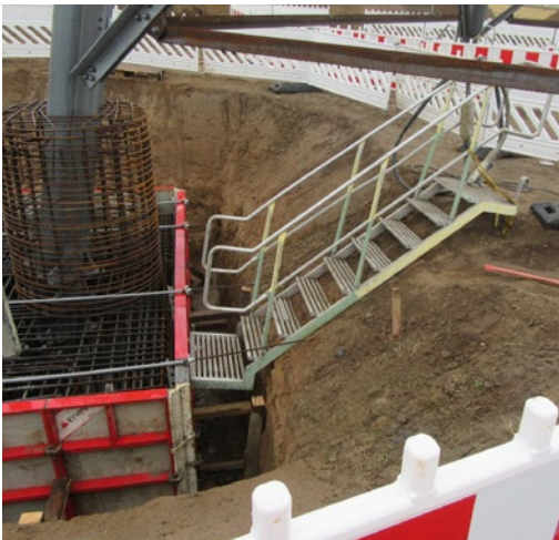
Abb. 150 Beispiel für eine Gitterrosttreppe als Zugang zu einer Mastgrube.
