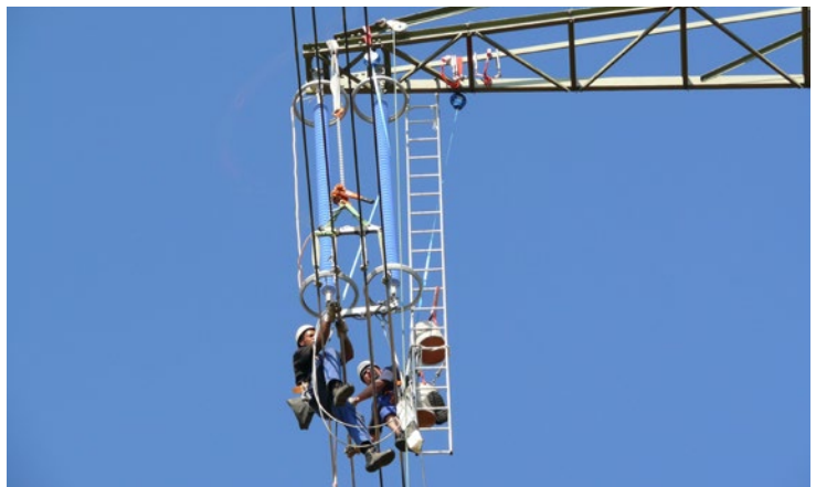
Abb. 48 Beispiel für ein HSG mit einem Drahtseil-Verbindungsmittel.
