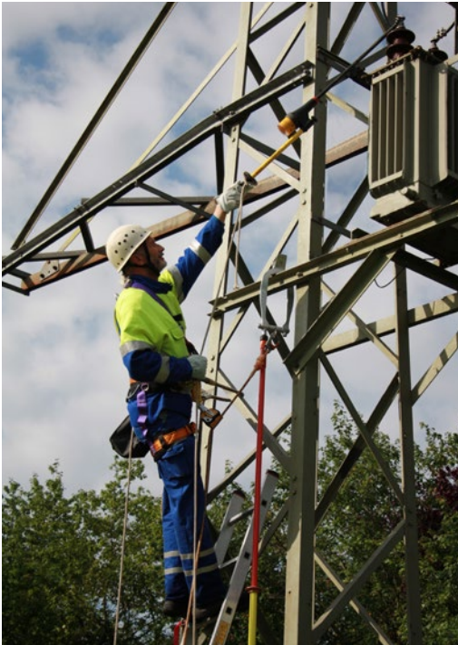
Abb. 94 Beispiel für den Einsatz einer Sprossenangeleiter bei der Feststellung der Spannungsfreiheit und dem Erden und Kurzschließen unter Verwendung geeigneter PSAGa und zusätzlich unter Verwendung eines Halteseils zur Arbeitsplatzpositionierung.
