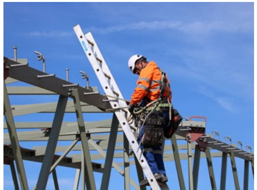
Abb. 155 Die Sicherung gegen seitliches Wegrutschen der Anlegeleiter an der oberen Anlegestelle ist durch die Steigbolzen gewährleistet. Der Versicherte ist mit seiner PSAgA in der Auffangfunktion gesichert und zusätzlich mit einem Halteseil positioniert.
