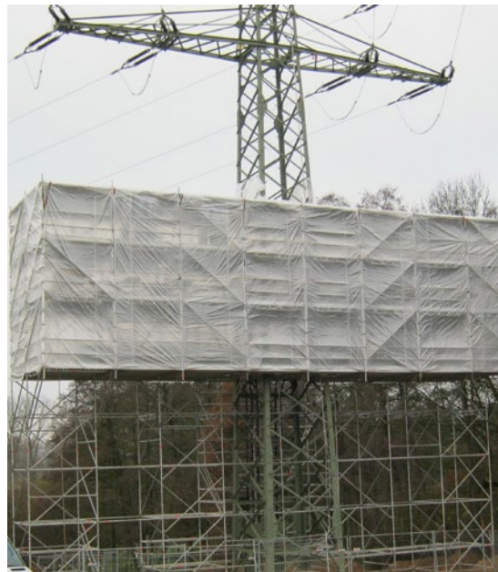
Abb. 7 Einsatz eines Gerüsts zur Montage von Kabelendverschlüssen an einem Freileitungsmast.
