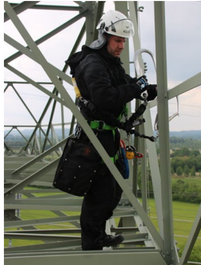
Abb. 63 Beispiel für den Einsatz eines Y-Seils. Die Verbindungen zwischen Falldämpfer, Rohrhaken und Verbindungsmittel sind mit Wirbeln ausgeführt.
