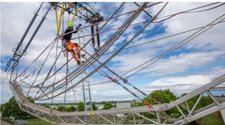
Abb. 117 Beispiel für den gesicherten Zustieg von einer Traverse auf eine Schlaufenbühne unter Verwendung einer Hängeleiter.
