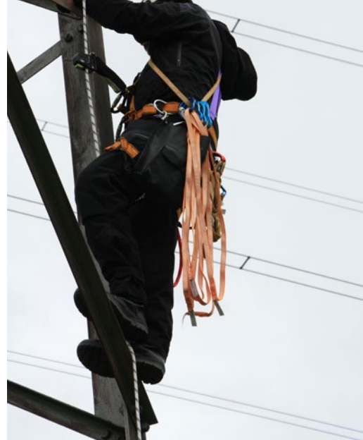
Abb. 70 Nach Befestigung des Sicherungsseils an einem Anschlagpunkt können weitere Versicherte mittels mitlaufendem Auffanggerät den Mast besteigen. Hierbei ist die Anzahl der gleichzeitigen Benutzer, bzw. Benutzerinnen gemäß Gebrauchsanleitung des jeweiligen Herstellers zu beachten.
