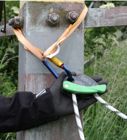
Abb. 68 Beispiel für ein am Mastfuß installiertes Sicherungsseil mit Seilbremse. Das Seil wird entsprechend dem Aufstieg aus dem Transportsack nachgeführt.
