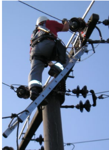
Abb. 116 Einsatz einer Abspannleiter mit verstellbarem Aufhängekopf.
