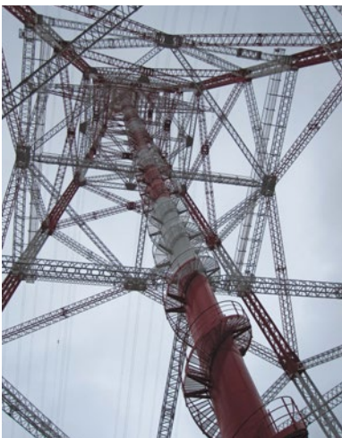
Abb. 2 Freileitungsmast mit Aufzugschacht, Bühnen und Treppen an der Elbekreuzung.
