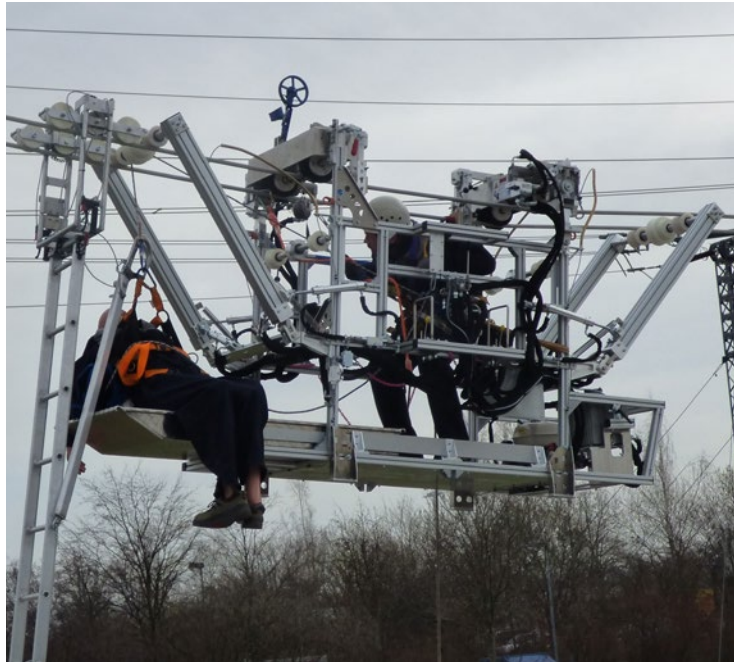
Abb. 141 ... und kann aus dieser Position ohne Behinderungen durch Konstruktionsteile des Leitungsfahrzeugs abgeseilt werden.
