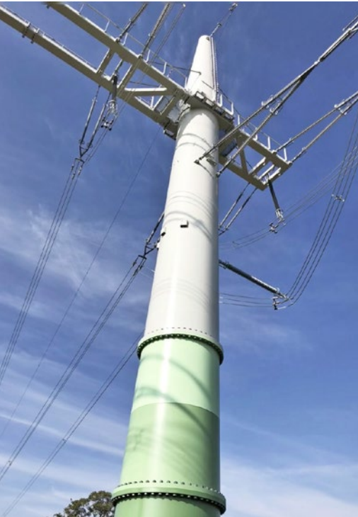
Abb. 3 Freileitungen des Typs Compact-Line bieten mit ihrer Bauweise als Stahlvollwandmaste die Möglichkeit zum Besteigen im Inneren der Maste.
