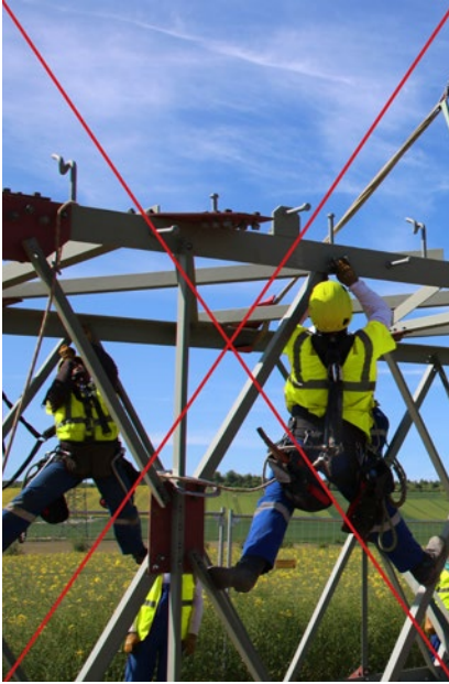
Abb. 152 Vormontagearbeiten ohne Einsatz von Arbeitsmitteln für einen sicheren Stand der Versicherten, wie z. B. Hubarbeits- oder Montagebühnen, sind mit erheblichen ergonomischen Belastungen verbunden.
