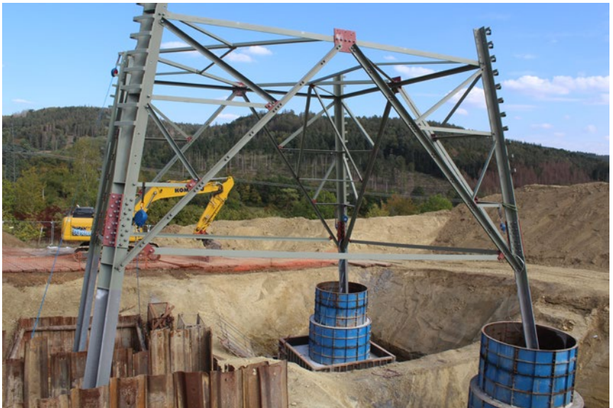
Abb. 160 Beispiel für eine Baugrube mit errichtetem Fußstuhl vor der abschließenden Betonierung und Verfüllung der Grube.
