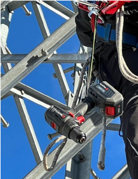
Abb. 95 Beispiel für die Verwendung einer Bandsicherung gegen Herabfallen eines Elektrowerkzeugs.
