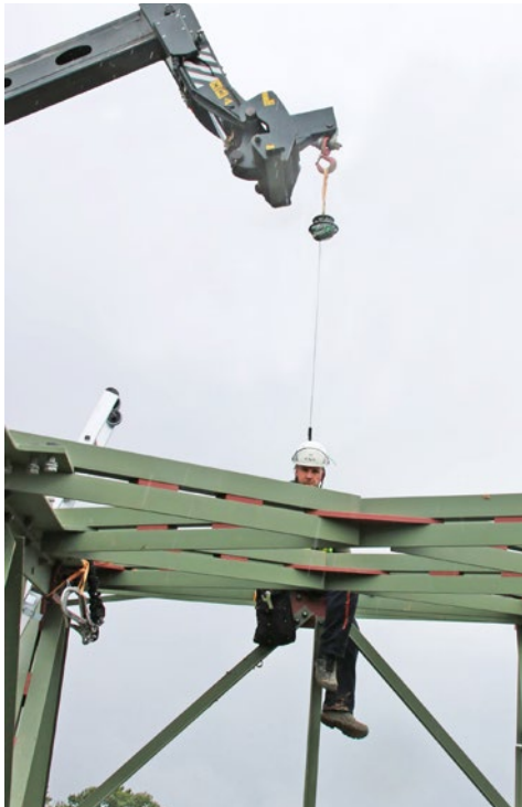
Abb. 159 Beispiel für eine Sicherung mittels Höhensicherungsgerät am Kran bei Montagearbeiten auf einem Deckel. Bei Auswahl der Arbeitsposition ist die zulässige Auslenkung des Verbindungsmittels des HSG gemäß Herstellerangabe zu beachten.
