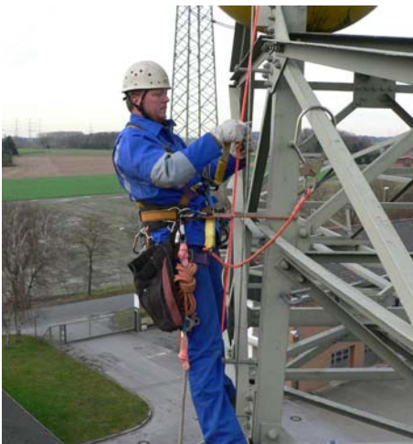
Abb. 13 Nach gesichertem Aufstieg am Mastschaft durch die Verwendung eines mitlaufenden Auffanggerätes an beweglicher Führung steigt der Versicherte auf eine Traverse um. Vor dem Lösen des Auffanggerätes hat sich der Versicherte mittels Verbindungsmittel an der Traversenkonstruktion gesichert. Der Einsatz des Halteseils stellt keine Maßnahme zum Schutz gegen Absturz dar und dient lediglich der Positionierung des Versicherten am Arbeitsplatz.
