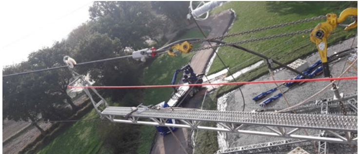
Abb. 110 Die mit der Traverse verbundene Bühne wird in die Arbeitsposition gezogen und am Leiterseil eingehängt.
