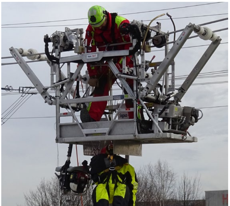
Abb. 142 Nach Vorbereitung des Abseilvorgangs wird die zu rettende Person über die geöffnete Bodenluke des Leitungsfahrzeugs abgeseilt.
