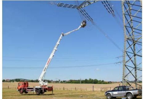
Abb. 2 Einsatz einer Hubarbeitsbühne für Arbeiten an einem Leiterseil unterhalb einer Abspannkette
