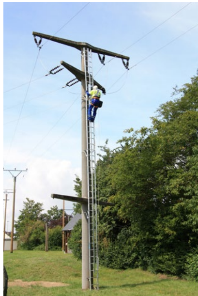
Abb. 87 Vollständig montierte Maststeigleiter mit integrierter fester Führung nach DIN EN 353-1.
