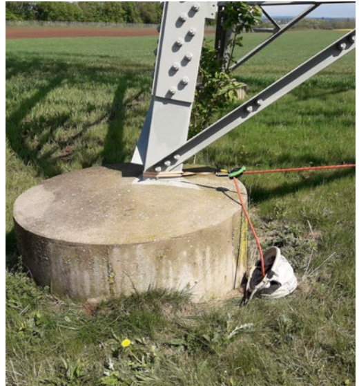
Abb. 68 Beispiel für ein am Mastfuß installiertes Sicherungsseil mit Seilbremse. Das Seil wird entsprechend dem Aufstieg aus dem Transportsack nachgeführt.
