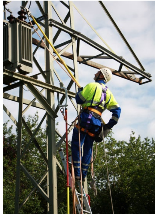
Abb. 94 Beispiel für den Einsatz einer Sprossenangeleiter bei der Feststellung der Spannungsfreiheit und dem Erden und Kurzschließen unter Verwendung geeigneter PSAGa und zusätzlich unter Verwendung eines Halteseils zur Arbeitsplatzpositionierung.
