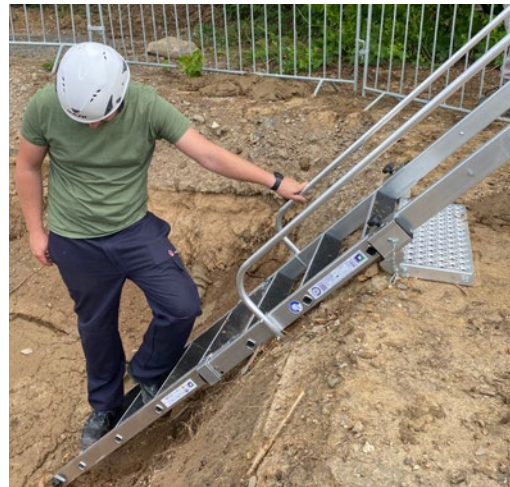
Abb. 151 Beispiel für den Zugang in eine Mastgrube unter Verwendung einer für diese Verwendung konstruierten Leiter.
