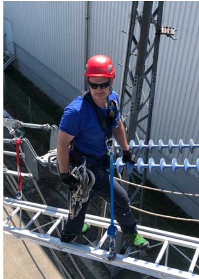
Abb. 106 Ein speziell konfektioniertes Höhensicherungsgerät verbindet die Anschlagseinrichtung mit dem Auffanggurt.
