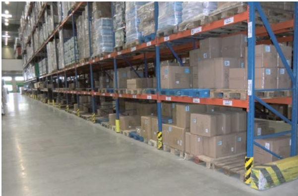
Abb. 19 Stützenschutz an allen Stützen
