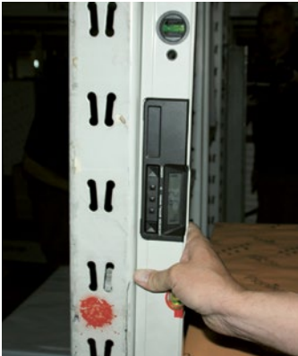
Abb. 10 Messung der Schiefstellung mit digitaler Wasserwaage
