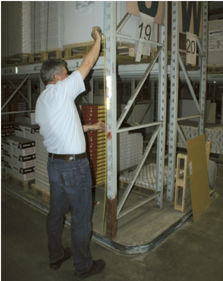
Abb. 6 Überprüfung der Fachhöhe
