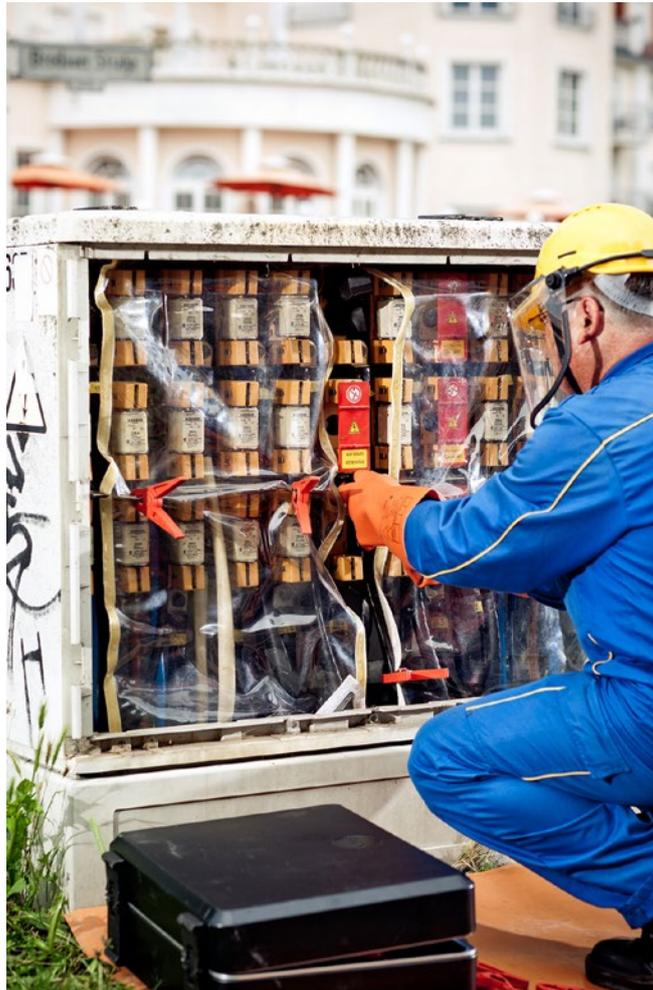
Abb. A 6-3 Arbeiten am Kabelverteilerschrank:  $k_T = 1,5$
