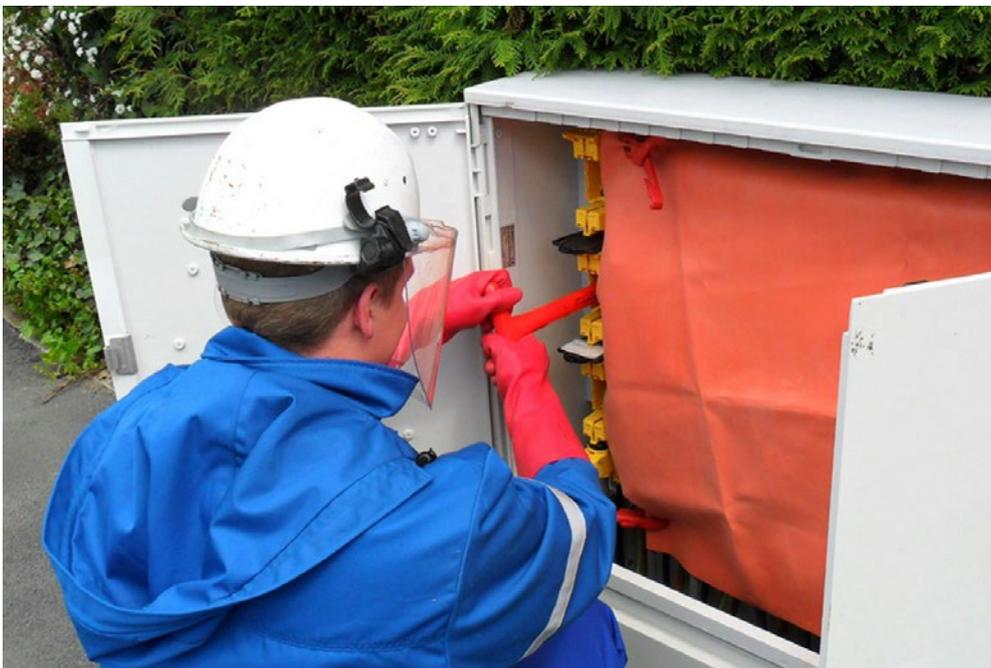
Abb. A 6-2 Wechsel einer Sicherungsleiste im Schaltschrank (nahe der Seitenwand):  $k_T = 1,0$
