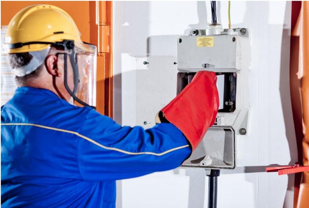
Abb. A 6-1 Arbeiten am Hausanschlusskasten:  $k_T = 1,0$
