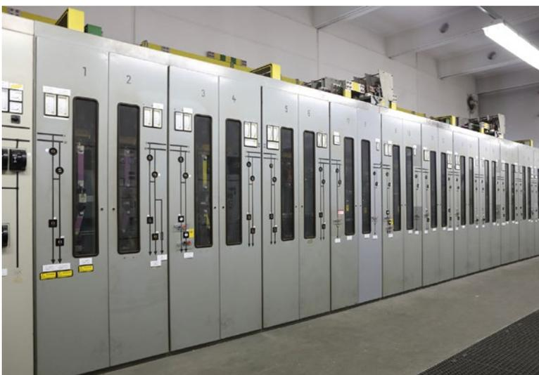
Abb. A 5-17 Leistungsstarke Schaltanlage älterer Bauart; eingesetzt in der Industrie
