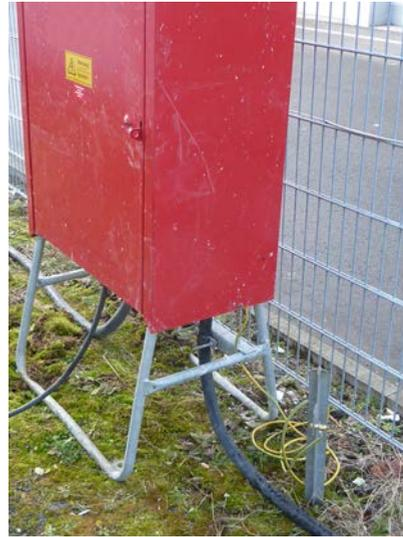
Abb. 4 Beispiel für eine fachgerechte und zuverlässige Ausführung der Erdung
