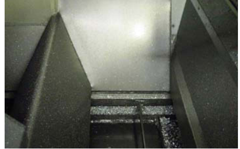
Bild 24 großflächige Öffnungen in den Späneförderer
