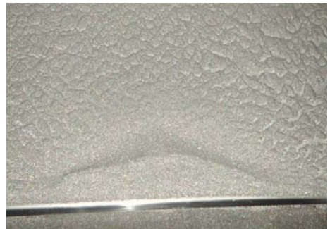
Bild 49 Anbackungen auf den Blechen
