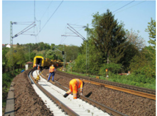
Abb. 3-8: Offensichtliche Fehler in der Ausführung der Sicherungsleistung – links: der Arbeitsbereich ist vom Warnsystem nicht vollständig abgedeckt, rechts: die Warnsignale sind für die Schraubmaschinenbediener nicht hörbar – muss der Verantwortliche des Bauunternehmens erkennen und abstellen lassen.
