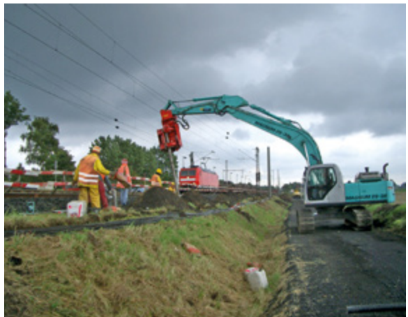
Abb. 4-2: Einsatz einer Ramme in der Nähe unter Spannung stehender Teile der Oberleitungsanlage.
