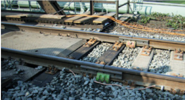
Abb. 4-11: Vor dem Durchtrennen der Fahrschiene wird eine elektrisch leitfähige Verbindung für den Rückstrom angebracht.
