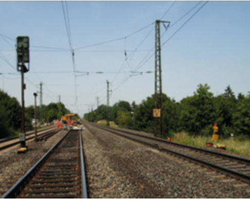
Abb. 3-8: Offensichtliche Fehler in der Ausführung der Sicherungsleistung – links: der Arbeitsbereich ist vom Warnsystem nicht vollständig abgedeckt, rechts: die Warnsignale sind für die Schraubmaschinenbediener nicht hörbar – muss der Verantwortliche des Bauunternehmens erkennen und abstellen lassen.
