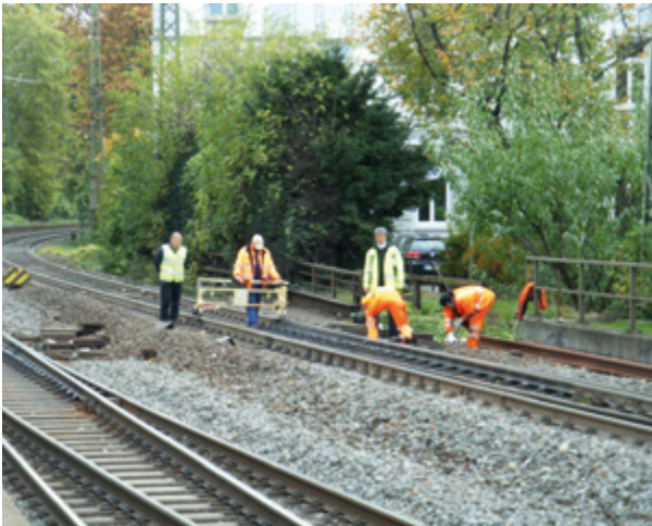
Abb. 6-2: Messarbeiten an einer Weiche (Arbeitsgleis gesperrt), Warnwesten sind geschlossen zu tragen.
