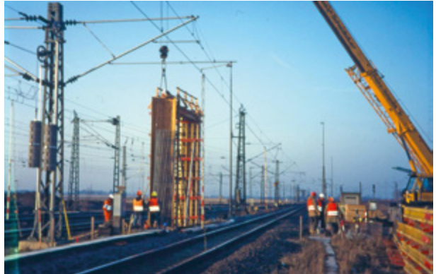
Abb. 4-5: Kranarbeiten bei ausgeschalteter Fahrleitung: Vor und hinter der Arbeitsstelle ist eine Bahnerdungsvorrichtung eingebaut.
