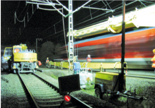
Abb. 3-2: Beim Transport vorgefertigter Weichenteile mit einem Schienenkran ist die gesamte Länge zwischen Montageplatz und Einbaustelle in die Sicherung einzubeziehen.
