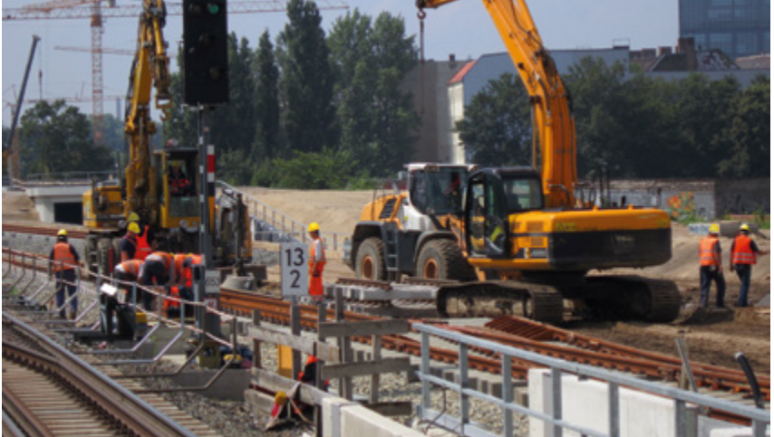
Abb. 12-1: Die Feste Absperrung bildet eine klare Trennung zwischen Arbeitsbereich und Gleisbereich.
