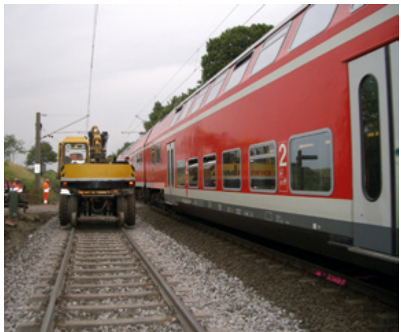
Abb. 7-19: Am eingeleisten Zweiwegebagger ist die Schwenkbegrenzung und unter Fahrleitung auch die Hubbegrenzung in Betrieb zu nehmen.
