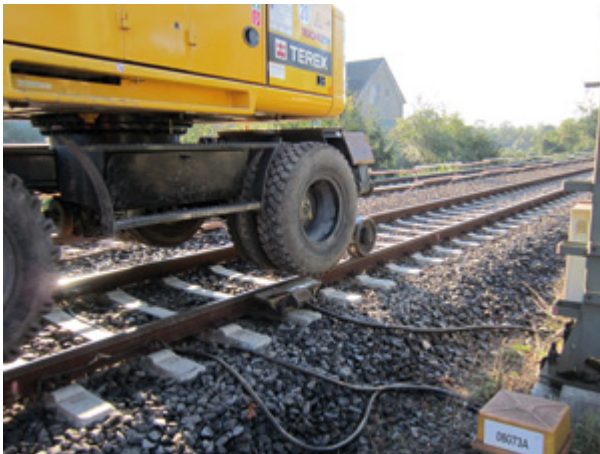
Abb. 7-12: Ausheben des Mobilfahrwerks am Indusi-Gleismagnet.
