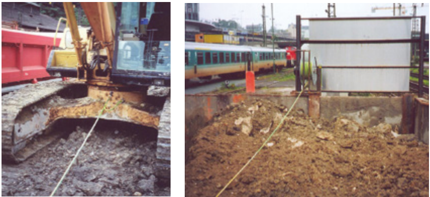
Abb. 4-6: Bagger mit Kabeltrommel zum Aufwickeln der Schlepperde.
