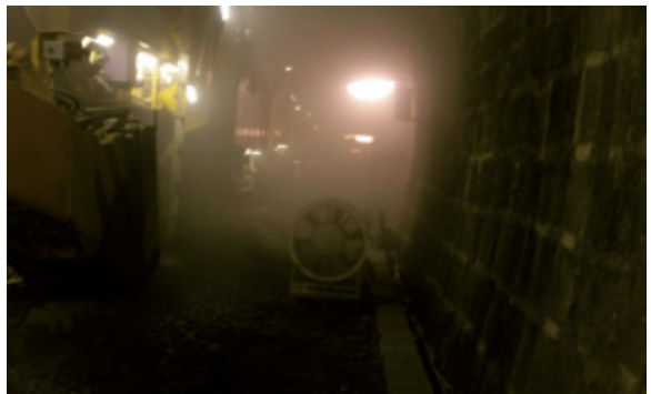
Abb. 11-2: Technische Lüftung bei Bettungsreinigungsarbeiten im Tunnel.
