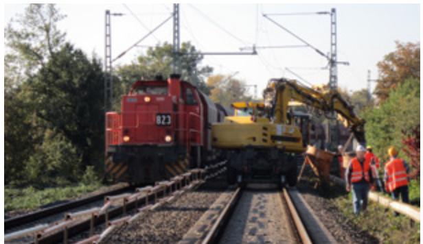
Abb. 2-5: Einsatz einer Festen Absperrung im Mittelkern bei 4 m Gleisabstand (80 km/h im Nachbargleis, Lü während der Arbeiten ausgeschlossen).
