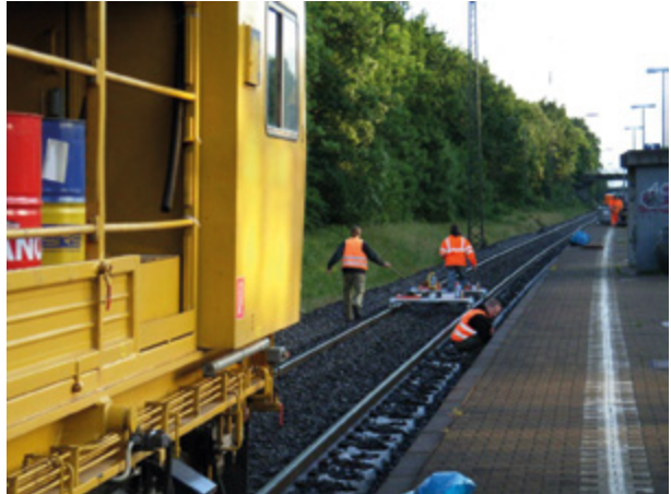
Abb. 9-3: Versetzbewegung einer Stopfmaschine im Baugleis nach rück- wärts. Der in Bewe- gungsrichtung vordere Führerstand ist hier nicht besetzt.
