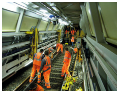
Abb. 9-8: Mobile Instandhaltungseinheit mit geschütztem Arbeitsraum (rechts) und integrier-tem Sozialraum (Hersteller: ROBEL Bahnbaumaschinen GmbH).
