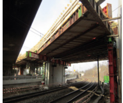
Abb. 12-17: Geschlossene Schutzwand über der Gleisanlage, um Materialabsturz und Gefährdung durch die Fahrleitung auszuschließen (Pfeilerbereiche: 3-teiliger Seitenschutz ist zu ergänzen). Die Höhe der Schutzwand richtet sich nach [38].
