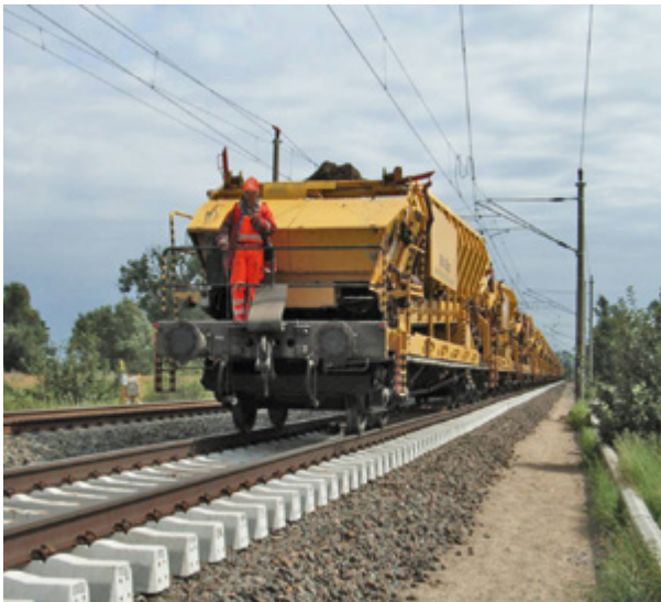
Abb. 10-1: Eine geschobene Rangierfahrt – hier Materialtransport für eine Planumsverbesserungsmaschine – muss von der Spitzenbesetzung vor Personen im Arbeitsgleis zum Halten gebracht werden können. Der Luftbremskopf ist an die Hauptluftleitung angeschlossen und wird bedienbereit gehalten.
