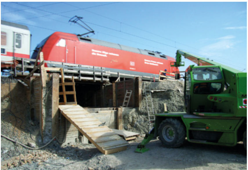
Abb. 12-12: Für den kurzzeitig in der Nähe des Gleisbereichs eingesetzten Teleskopstapler besteht die Gefahr einer unbeabsichtigten Annäherung an die Fahrleitung. Es wird eine Bahnerdung eingesetzt.
