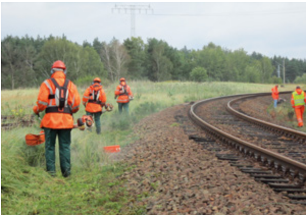
Abb. 12-23: Bei der Vegetationspflege mit schneller Durcharbeitung außerhalb des Gleisbereichs kann der Einsatz automatischer Warnsysteme mit individuellen Warngeräten sicherheitstechnisch gerechtfertigt sein.
