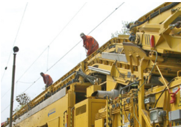
Abb. 8-9: Bei Arbeiten an hochliegenden Förderbändern muss die Oberleitung ausgeschaltet und bahngeerdet sein. Zum Schutz vor Absturz ist Anseilschutz einzusetzen.
