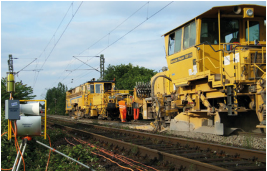
Abb. 9-1: Stopfmaschine (im Hintergrund, mit Messtrupp) und Schotterplaniermaschine.
