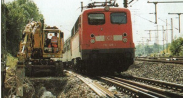
Abb. 7-20: Zweiwegebagger auf Mobilfahrwerk neben Betriebsgleis.
