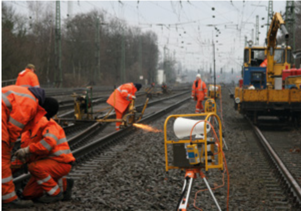
Abb. 2-15: Mobile funkangesteuerte Signalgeber für kleine oder schnell wandernde Arbeitsstellen (Foto: Zöllner Signal GmbH). Bei Arbeiten mit Funkenflug muss die Warnkleidung schwerentflammbar sein.
