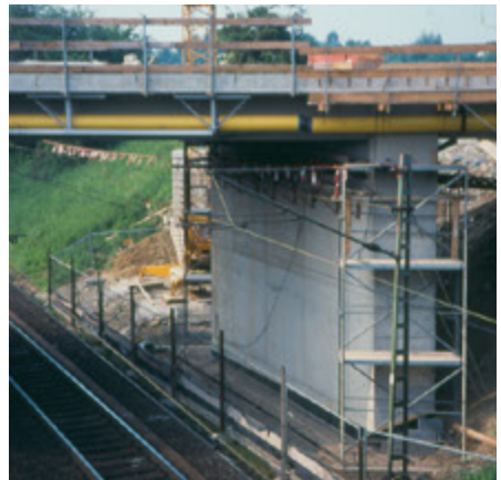
Abb. 1-1: Beispiel zum Gleisbereich: Beim Hantieren mit Gerüstrohren neben dem Gleis besteht die Gefahr, in den durch Druck- und Sogeinwirkungen gefährdeten Bereich hineinzuweichen oder den Schutzabstand zu unter Spannung stehenden Teilen der Fahrleitungsanlage zu unterschreiten. Der Gleisbereich umfasst in diesem Fall auch die Arbeitsplätze der Gerüstbauer. Bei der DB schließt der Gleisbereich den Gefahrenbereich ein (vgl. Anhang 3).
