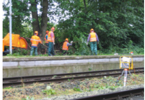
Abb. 12-21: Vegetationspflege: Sicherung mit händisch mitgeführten Signalgebern.
