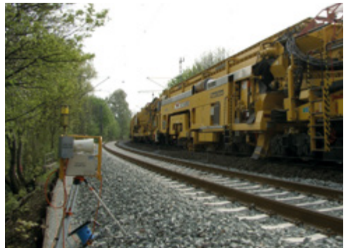
Abb. 2-12: Automatisches Warnsystem auf der Feldseite des Betriebsgleises zur Sicherung einer Planumsverbesserungsmaschine, deren Maschinenwarnanlage von der feldseitigen Warnsystemzentrale angesteuert wird.
