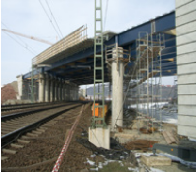
Abb. 12-17: Geschlossene Schutzwand über der Gleisanlage, um Materialabsturz und Gefährdung durch die Fahrleitung auszuschließen (Pfeilerbereiche: 3-teiliger Seitenschutz ist zu ergänzen). Die Höhe der Schutzwand richtet sich nach [38].
