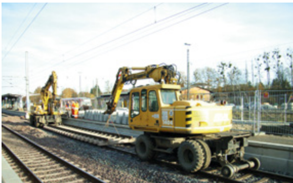
Abb. 7-5: Transport eines Gleisjochs: die Rückwärtsfahrt ist unvermeidbar.
