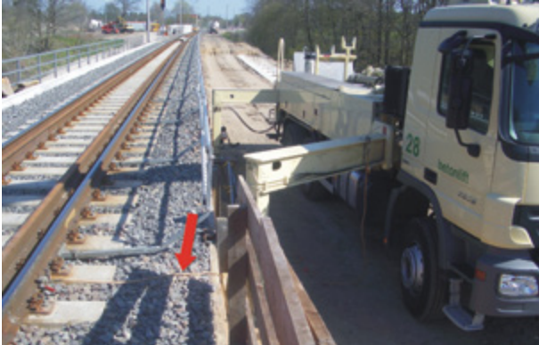
Abb. 12-4: Erdungsanschluss für eine Betonpumpe.
