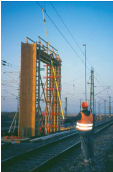
Abb. 4-4: Feststellen der Spannungsfreiheit durch Fachpersonal vor Arbeitsbeginn.
