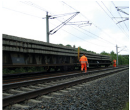
Abb. 8-7: Der für Materialwagen zu sichernde Bereich ragt am Baulosanfang und/oder Baulosende weit über das Ende des bearbeiteten Gleisabschnitts hinaus (links: Bunkerschüttgutwagen einer Planumsverbesserungsmaschine, rechts Schwellenwagen eines Umbauzuges).
