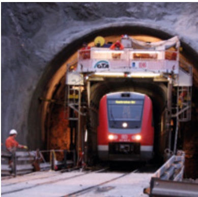
Abb. 12-2: Behelfsübergang für Arbeitskräfte und Maschinen, der nach Gleisspernung benutzt wird.
