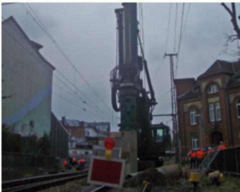
Abb. 12-6: Einsatz eines Drehbohrgerätes im Gleisbereich.
