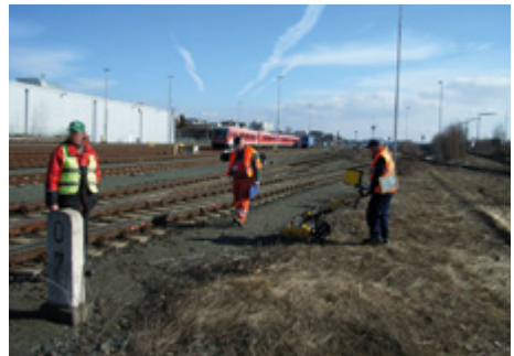
Abb. 12-25: Kampfmittelerkundung in einem Bahnhof bei gesperrtem Nachbargleis.
