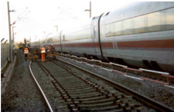
Abb. 2-2: Am Schienenfuß montierte Feste Absperrung zwischen Arbeitsbereich und Betriebsgleis bei 4,7 m Gleisabstand.
