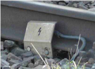
Abb. 4-12: Rückleiter und Erdungsleiter, z. B. von elektrischen Weichenheizanlagen: die Abdeckbleche dürfen nur durch anlagenspezifisch unterwiesene Elektrofachkräfte mit Beauftragung durch den Anlagenverantwortlichen gelöst werden.
