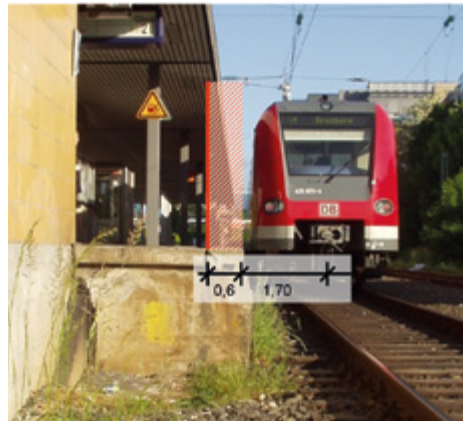
Abb. 12-20: Grenze des Gleisbereichs auf dem Bahnsteig für eine Geschwindigkeit von 120 km/h im Bahnsteiggleis.
