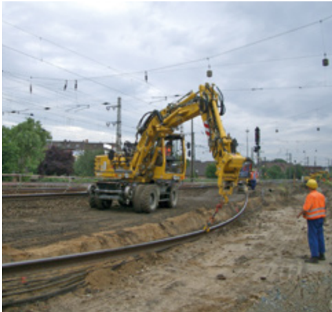
Abb. 7-1: Anschläger im Sichtbereich des Maschinenführers. Warnkleidung ist geschlossen zu tragen.
