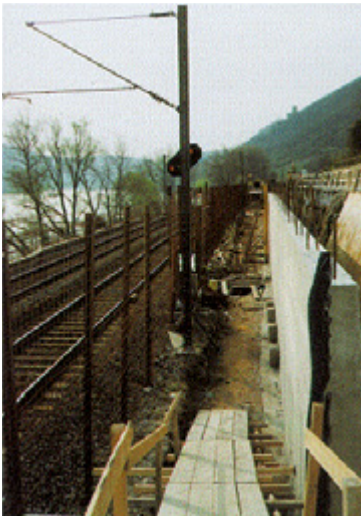
Abb. 12-14: Bauzaun als feste Absperrung zwischen Brückenwiderlager und Gleisanlage.
