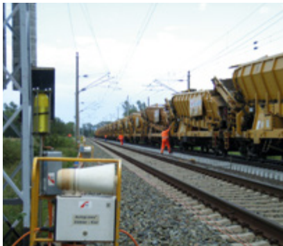
Abb. 8-7: Der für Materialwagen zu sichernde Bereich ragt am Baulosanfang und/oder Baulosende weit über das Ende des bearbeiteten Gleisabschnitts hinaus (links: Bunkerschüttgutwagen einer Planumsverbesserungsmaschine, rechts Schwellenwagen eines Umbauzuges).
