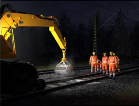
Abb. 22 Gleisoberbauarbeiten: Empfehlung Warnkleidung Klasse 3
