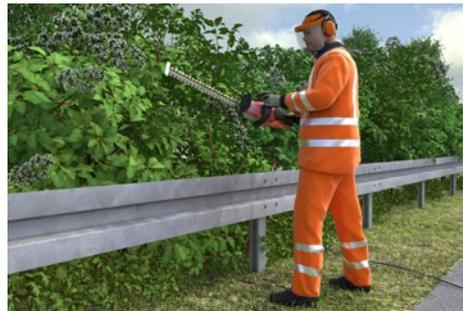
Abb. 15 Erhöhte Gefährdung, Warnkleidung Klasse 3, a: Latzhose oder Rundbundhose mit Warnweste A, b: Rundbundhose oder Latzhose mit Jacke D
