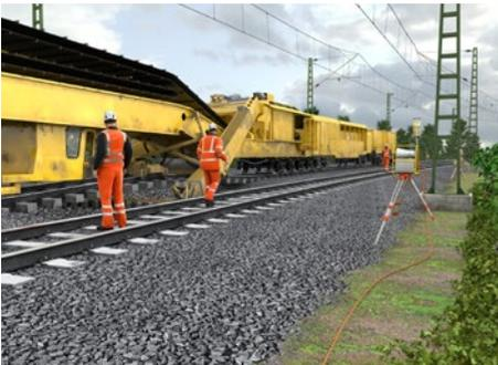
Abb. 23 Maschinenbediener im Nachbargleis: Empfehlung Warnkleidung Klasse 3
