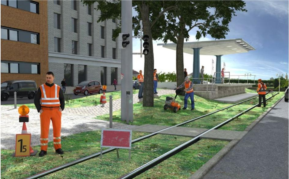
Abb. 25 Vegetationspflegearbeiten im Gleisbereich von Straßenbahnen:
