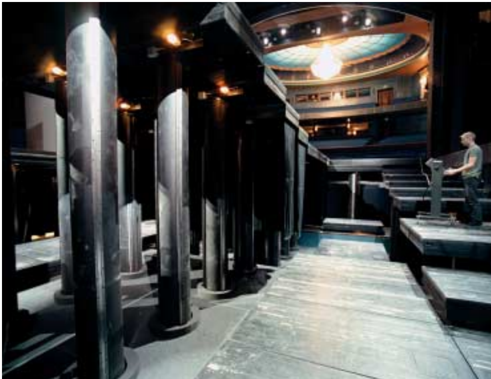
Bild 12: Maschinentechnische Einrichtung der Untermaschinerie
