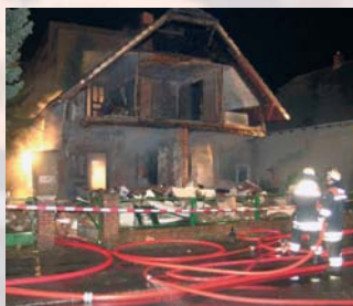
Fassadeneinsturz nach Explosion
