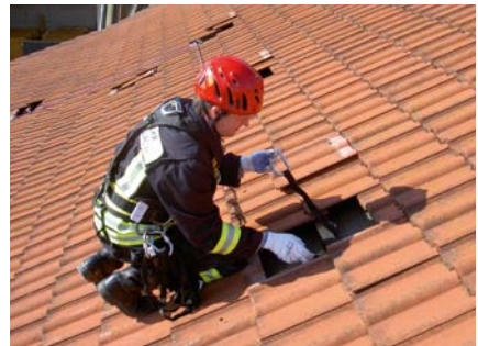
Arbeiten auf Dächern
