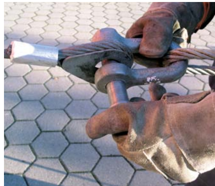
Zugseile und Anschlagseile nur mittels Schäkel verbinden.
