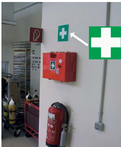
Verbandkasten an leicht zugänglicher Stelle – das Rettungszeichen E03 „Erste Hilfe“ weist darauf hin.
