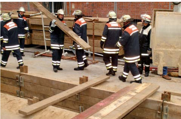
Behelfsmäßiger Übergang aus Bohlen
