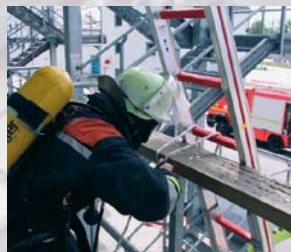
Sicherung des Leiterkopfes gegen Abrutschen
