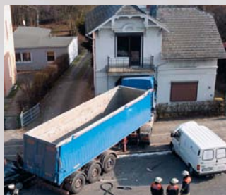
Einsturz einer Hauswand durch äußere Schadenseinwirkung
