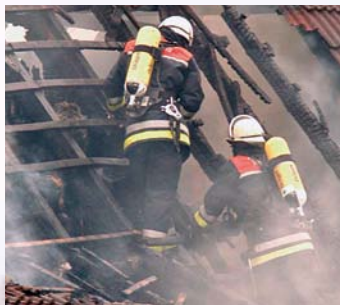
Durchbruchgefahr! Unsicherer Stand auf angebrannten Dachlatten
