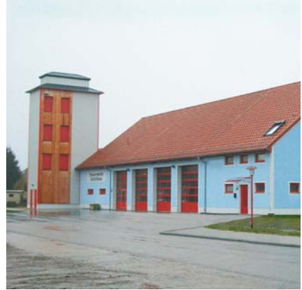
Der Ausfahrtbereich des Feuerwehrhauses ist für Verkehrsteilnehmer gut erkennbar.
