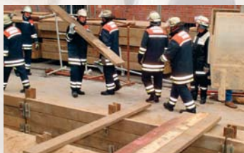
Behelfsmäßig hergestellter Über- gang aus Bohlen
