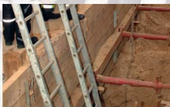
Sicherer Zugang in den Graben über Leitern
