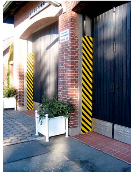
Gelb-schwarze Gefahrenkennzeichnung der Tordurchfahrt nach außen
