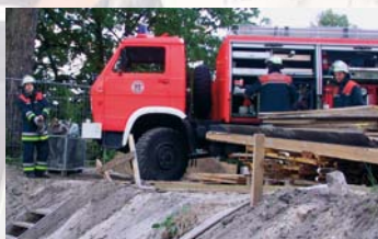
An Kanten von Baugruben und Gräben nicht dichter als 2 m heran- fahren (Schutzstreifen).
