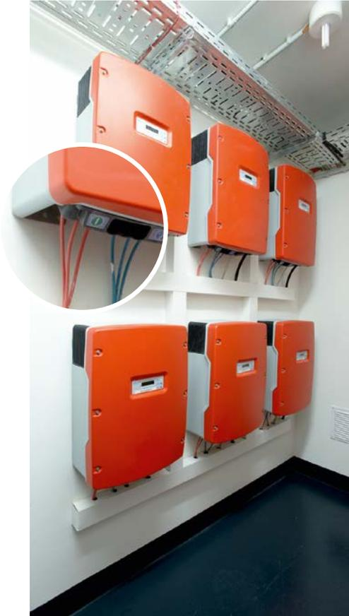
**Abb. 19** Wechselrichter können, je nach Gebäude-situation, wie hier im Hausanschlussraum oder aber auch an anderer Stelle installiert sein. Links unten an den Wechselrichtern sind die integrierten DC-Freischalter zu erkennen. PV-Anlagen sind unter Umständen erst dann vollständig freigeschaltet, wenn an allen beteiligten Wechselrichtern der DC-Freischalter betätigt wurde.
