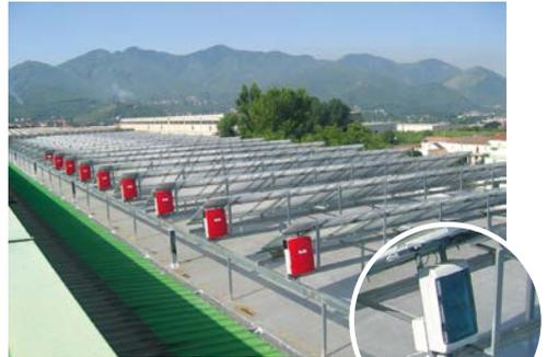
**Abb. 18** Mehrere Leitungen des PV-Modulfeldes werden in Generatoranschlusskästen zusammengeführt. Von hier aus gelangen die Hauptleitungen zum Wechselrichter. Die einzelnen Modulleitungen sind untereinander mit Steckverbindern gekoppelt. Diese dürfen nicht geöffnet werden, da dabei die Gefahr eines Lichtbogens besteht.
