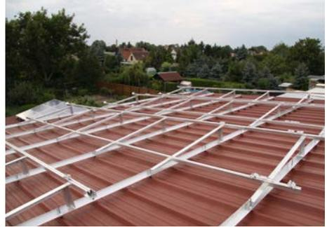
**Abb. 16** Durch das Montagegestell sind die Module fest mit dem darunter liegenden Dach verbunden. Die eingesetzten Verbindungstechniken können nicht ohne weiteres entfernt werden, damit sie Schnee und Sturm standhalten. Die Befestigung stellt auch einen wichtigen Teil des Diebstahlschutzes dar.
