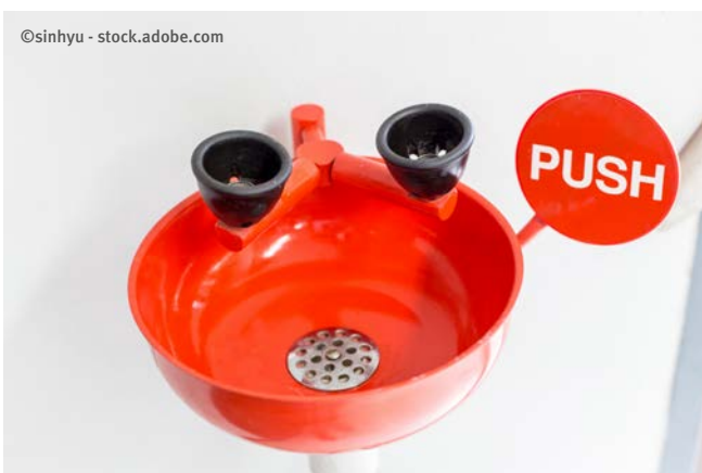
Abb. 4 und 5 Beispiel einer Augendusche und Rettungszeichen E011 Augenspüleinrichtung
