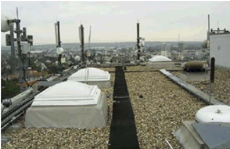
Abb. 7.1.1: Der Verkehrsweg lässt mit seinem Abstand von \geq 2 m einen Absturz über die Dachkante nicht erwarten. Laut Musterbauordnung ist eine Ausführung der Lichtkuppeln bei einer Randhöhe von \geq 0,50 m ohne zusätzliche Sicherungsmaßnahmen an Verkehrswegen erlaubt.
