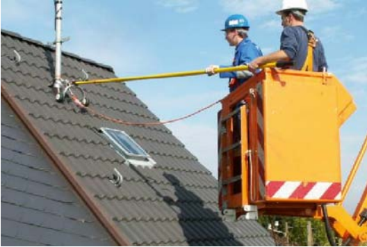
Abb. 4.2.2: Vorbereitung zum Aussteigen aus dem Arbeitskorb. Zum Schutz vor Absturz befestigt der Mitarbeiter mittels einer Teleskopstange ein Sicherungsseil am Dachständer, der als Anschlagpunkt dient.
