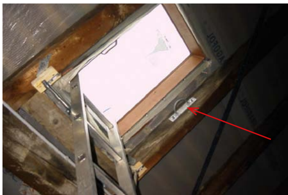
Abb. 5.3.1: Der Dachausstieg verfügt über eine seitlich am Dachsparren angebrachte Anschlagvorrichtung nach DIN EN 795 (roter Pfeil) zum Einsatz persönlicher Schutzausrüstungen gegen Absturz. Der Anschlagpunkt muss entsprechend Abb. 5.3.2 gekennzeichnet sein.
