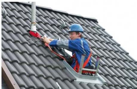
Abb. 7.5.2.1: Beispiel 1: Vor dem Aussteigen aus der Dachluke wird mittels Bandschleufe ein Anschlagpunkt am Dachständer eingerichtet. Das Sicherheitsseil wird mittels Karabinerhaken an der Bandschleufe befestigt.
