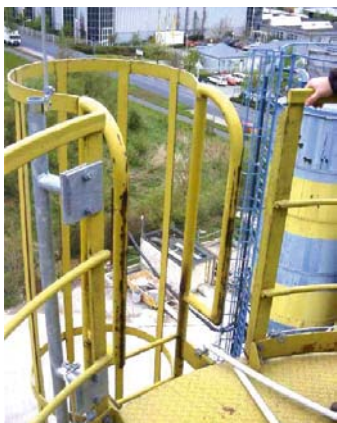
Abb. 4.1.2: Ab einer Absturzhöhe > 10 m verfügen Steigleitern über Steigschutzeinrichtungen
