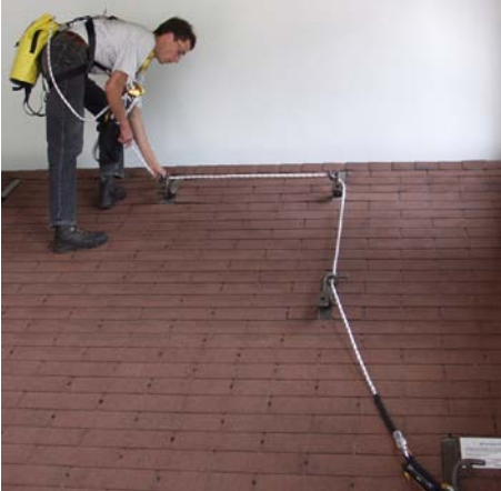
Abb. 5.3.5: Einsatz einer Dachspirale
