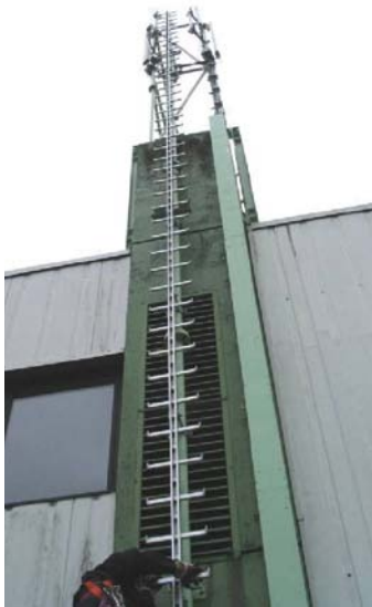
Abb. 4.1.2: Ab einer Absturzhöhe > 10 m verfügen Steigleitern über Steigschutzeinrichtungen
