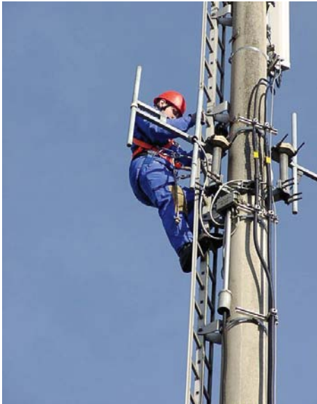
Abb. 7.5.3.1: Mitarbeiter auf der Steigleiter eines Antennentragwerkes. Die Sicherung zur Steigschutzschiene erfolgt hier über das Auffanggerät zur Steigschutzöse. Vor Arbeitsaufnahme sichert sich der Beschäftigte zusätzlich über sein Halteseil.
