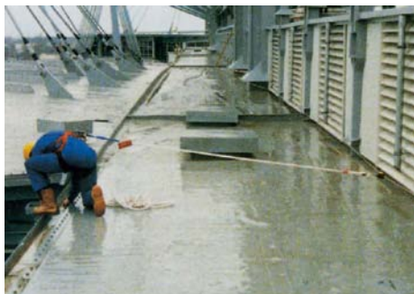
Abb. 7.5.1.2: Das Bild zeigt eine Anschlagkonstruktion, bestehend aus einem gespannten Drahtseil. Das Verbindungsmittel ist über einen beweglichen Anschlagpunkt mit dem Drahtseil verbunden.
