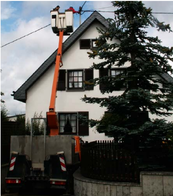
Abb. 4.2.1: Arbeiten an einem Dachständer mittels Hubarbeitsbühne
