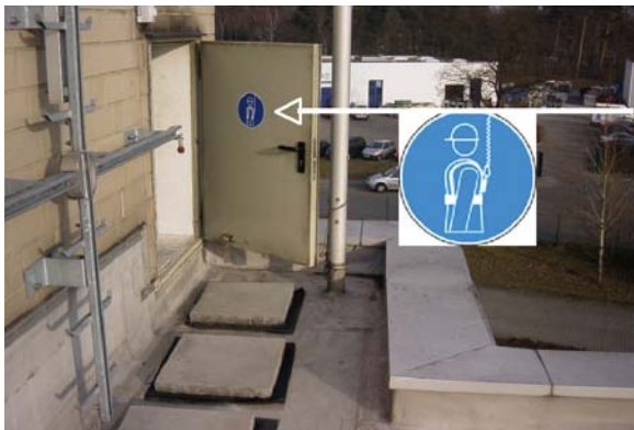
Abb. 5.2.2: Unmittelbar mit Betreten des „Flachdaches“ besteht Absturzgefahr! Das Gebotsschild am Dachausstieg weist auf die Benutzungspflicht der PSaGA hin. Der Verkehrsweg ist mit einer festen Führung zum Einsatz eines mitlaufenden Auffängergerätes ausgestattet.
