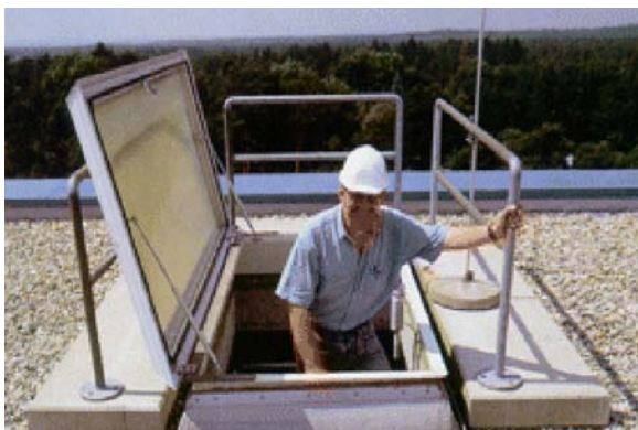
Abb. 5.2.3: Ausstieg auf ein „Flachdach“. Die Dachluke ist durch Hydraulikdämpfer leicht zu öffnen und gegen unbeabsichtigtes Zuschlagen gesichert. Die Umwehrung gibt den Zugang auf das Dach nur über den vorgesehenen Verkehrsweg frei.
