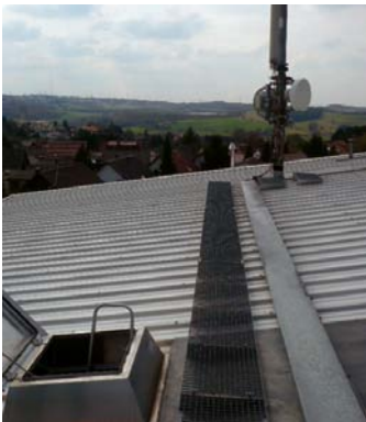
Abb. 6.1.1: Einsatz von Metallrosten zur Kennzeichnung und trittsicheren Gestaltung eines Verkehrsweges auf einem geneigten Blechdach.
