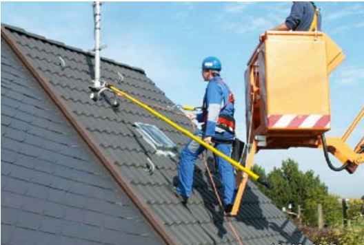
Abb. 4.2.3: Im nächsten Schritt verlässt der Mitarbeiter gesichert die Arbeitsbühne.
