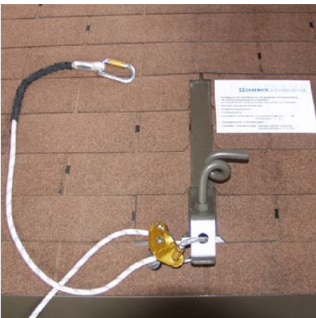
Abb. 5.3.6: Detaildarstellung der Dachspirale
