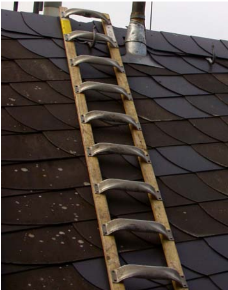
Abb. 6.2.2.1: Dachdeckerauflegeleiter im Sinne der Regel „Dacharbeiten“ (BGR 203). Die Leiter ist mindestens mit der vorletzten Sprosse einzuhängen.
