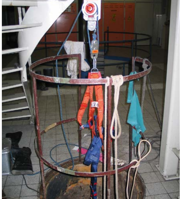
Abb. 4.5.3: Die Umwehung einer geöffneten Einsteigöffnung verhindert ein unge- wolltes Hineinstürzen von Personen.
