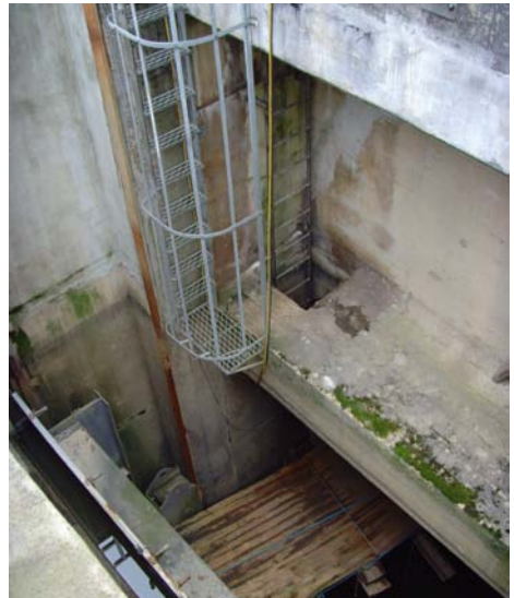
Abb. 4.4.2.5: Beispiel für einen Zugangsweg über eine Steigleiter und einen anschließenden Steigeisengang (rechte Abbildung) in den Turbinenraum. Die Absturzsicherung erfolgt durch ein ortsveränderliches kombiniertes Höhensicherungs- und Rettungshubgerät. Die im Beispiel gezeigte Rückenschutzeinrichtung ist im Rettungsfall hinderlich und muss demontiert werden.
