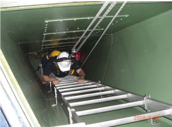
Abb. 9.2.4: Beispiel einer Rettungsübung an einer Steigleiter eines Schachtes
