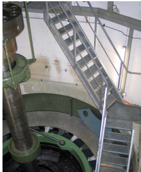
Abb. 6.1.1.8: Arbeitsbereich auf Ebene A gemäß Abb. 6.1.1.7. Der Arbeitsbereich kann über eine Treppe sicher erreicht werden.
