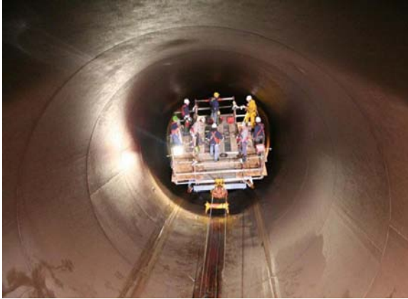
Abb. 6.5.2.1: Beispiel für einen Befahrwagen, z. B. für Korrosionsschutzarbeiten in einer Druckleitung. Der Befahrwagen wird über ein Windwerk mit Zugseilen bewegt. Die Konstruktion der Befahreinrichtung sowie der Ablauf des Befahrvorgangs sind unter Einbindung eines Gutachters festzulegen.
