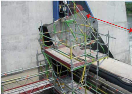
Abb. 6.4.6 und 6.4.7: Gesicherter Zugangsweg zu einem Wehrklappenkörper. Für die Errichtung dieses Zuganges ist PSA gegen Absturz erforderlich (Nutzung Seilführung).
