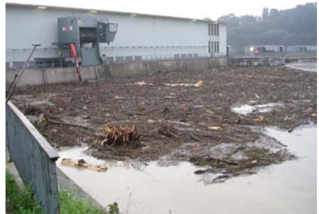
Abb. 6.2.1.3.1: Große Treibgutmengen vor dem Einlauf eines Wasserkraftwerkes
