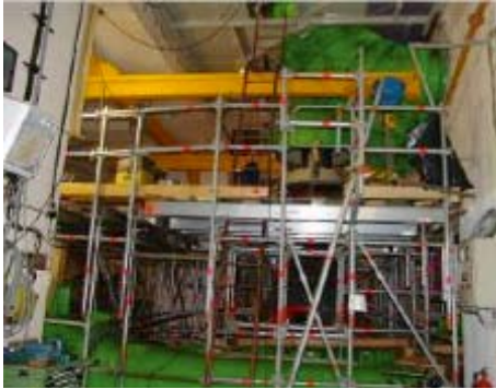
Abb. 4.3.3: Das Bild verdeutlicht den Aufwand zur Erstellung eines Gerüstes, das zur Durchführung von Arbeiten an einer Speicherpumpe erforderlich ist.
