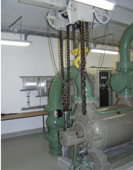
Abb. 4.3.8: Stationäre Hilfshebeeinrichtung ermöglichen erleichterte De- und Remontearbeiten an Anlageteilen.
