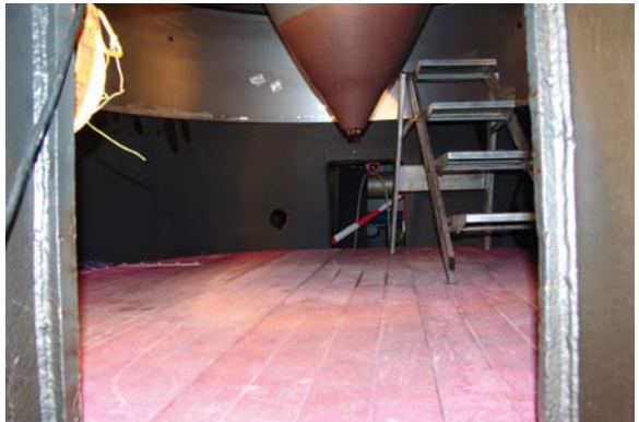
Abb. 6.1.1.12: Speziell eingepasste Arbeitsplatt- form auf Ebene C gemäß Abb. 6.1.1.7
