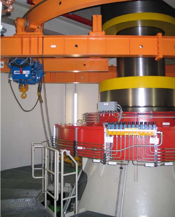
Abb. 6.1.1.2: Die vertikale Welle einer Francis- turbine besitzt teilweise keine Ver- kleidung. Der Schutz wird durch einen ausreichenden Abstand des Verkehrsweges zur Welle erreicht.
