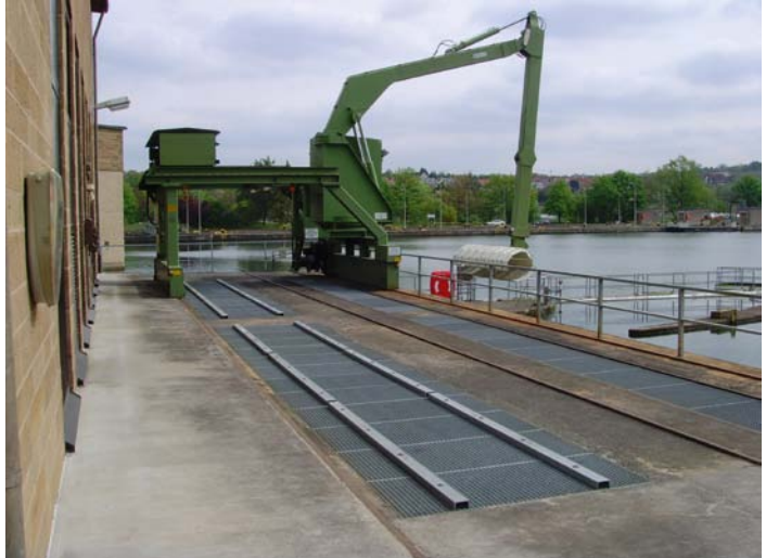
Abb. 6.2.1.1.2: Die Stolperstellen an den Aushebeprofilen der Gitterroste werden z. B. durch ein Versetzen der Profile auf die Unterseiten der Gitterroste konstruktiv beseitigt.
