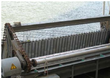
Abb. 6.3.3: Ansicht vom Oberwasserpodium
