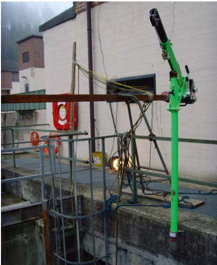
Abb. 4.4.2.5: Beispiel für einen Zugangsweg über eine Steigleiter und einen anschließenden Steigeisengang (rechte Abbildung) in den Turbinenraum. Die Absturzsicherung erfolgt durch ein ortsveränderliches kombiniertes Höhensicherungs- und Rettungshubgerät. Die im Beispiel gezeigte Rückenschutzeinrichtung ist im Rettungsfall hinderlich und muss demontiert werden.
