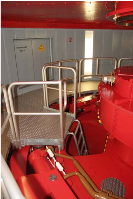
Abb. 4.3.1, Abb. 4.3.2: Feste Zugänge und Arbeitsbühnen für regelmäßige Wartungs- und Kontrolltätigkeiten
