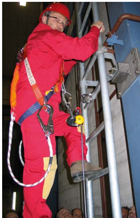
Abb. 4.4.2.4: Einsatz einer festen Steigschutzzeineinrichtung an einer Steigleiter. Die Steigschutzzeineinrichtung besteht aus einem gespannten Stahlseil, das nach Beendigung der Arbeiten wieder demontert werden kann, und dem zugehörigen mitlaufenden Auffanggerät.
