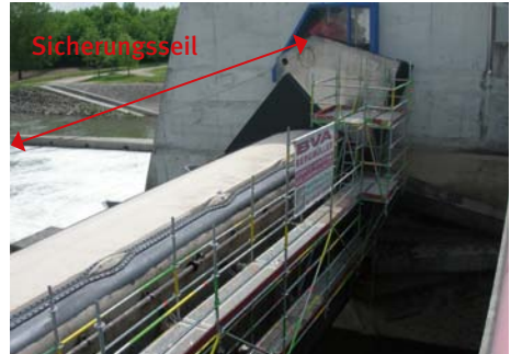
Abb. 6.4.6 und 6.4.7: Gesicherter Zugangsweg zu einem Wehrklappenkörper. Für die Errichtung dieses Zuganges ist PSA gegen Absturz erforderlich (Nutzung Seilführung).
