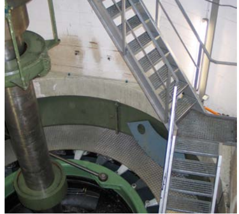
Abb. 4.4.1.4: Instandsetzungsarbeiten an einem unteren Turbinenführungslager. Der Zugang erfolgt über fest eingebaute Treppen, die an den engen Arbeitsraum über Zwischenpodeste angepasst sind.
