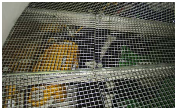
Abb. 6.1.1.5: Beispiel für eine Gitterrost- abdeckung eines Leitapparates. Zur verbesserten Zugänglichkeit sind die einzelnen Segmente klappbar ausgeführt.
