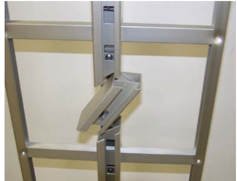
Abb. 4.4.2.2: Steigleiter mit Steigschutzeinrichtung. Die Weiche zum Einführen des mitlaufenden Auffängergerätes muss in der geschlossenen Position verriegelt sein.
