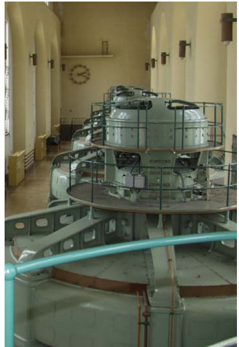
Abb. 4.3.1, Abb. 4.3.2: Feste Zugänge und Arbeitsbühnen für regelmäßige Wartungs- und Kontrolltätigkeiten
