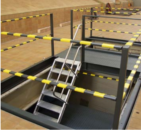
Abb. 4.4.1.3: Treppenabgang zu einer Absperreinrichtung
