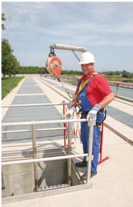
Abb. 4.4.2.3: Benutzung einer Steigleiter mit Sicherung gegen Absturz durch ein Höhensicherungsgerät, das an einem Anschlagpunkt oberhalb der Einstiegsöffnung befestigt ist. Als Anschlagpunkt kommt eine mobile Einrichtung zum Einsatz, die in Bodenhülsen eingesetzt wird.
