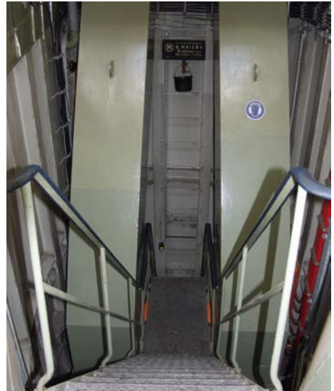
Abb. 4.4.1.2: Beispiel für einen Treppenabgang zu einer Turbinenanlage
