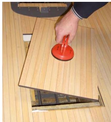
Abb. 41 Revisionsklappe – mit Hilfsmittel (z. B. Saugheber) zu öffnen
