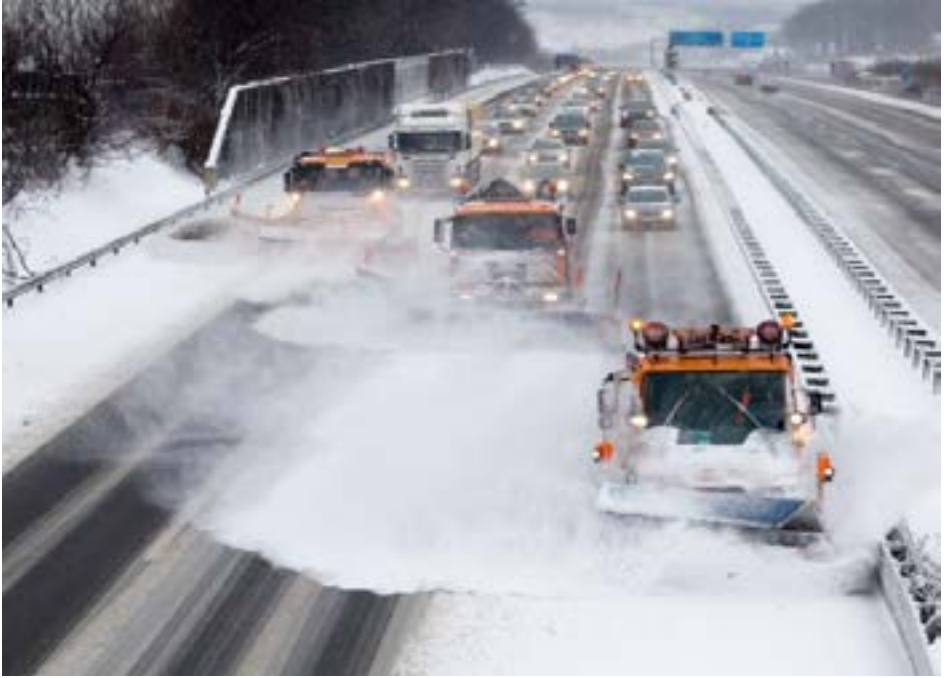
Abb. 5 Winterdienst auf der Autobahn im fließenden Verkehr (Quelle: Straßen.NRW)
