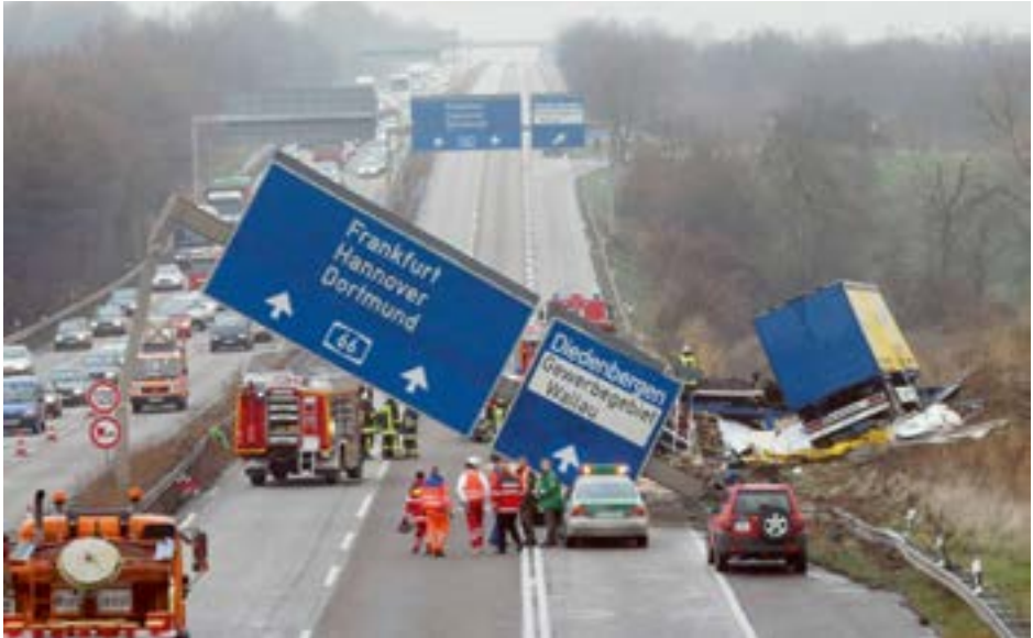
Abb. 8 Eingestürzte Schilderbrücke nach LKW-Aufprall
