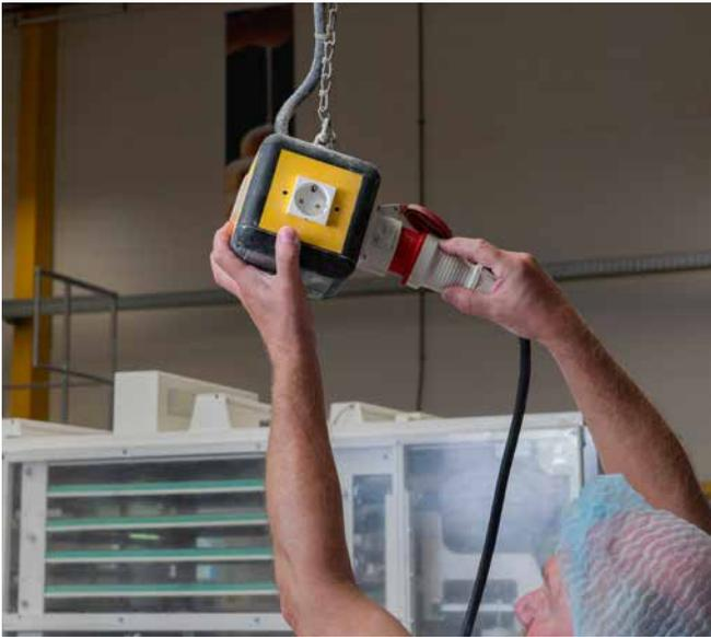
Abb. 8 Energiewürfel zum mobilen Anschluss von Maschinen und Geräten
