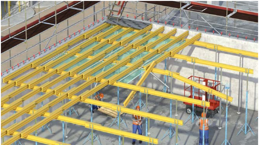
Abb. 10 Verlegen von Schalungsplatten von oben mit Schutznetzen (Sicherheitsnetzen), lichter Querträgerabstand > 30 cm.
