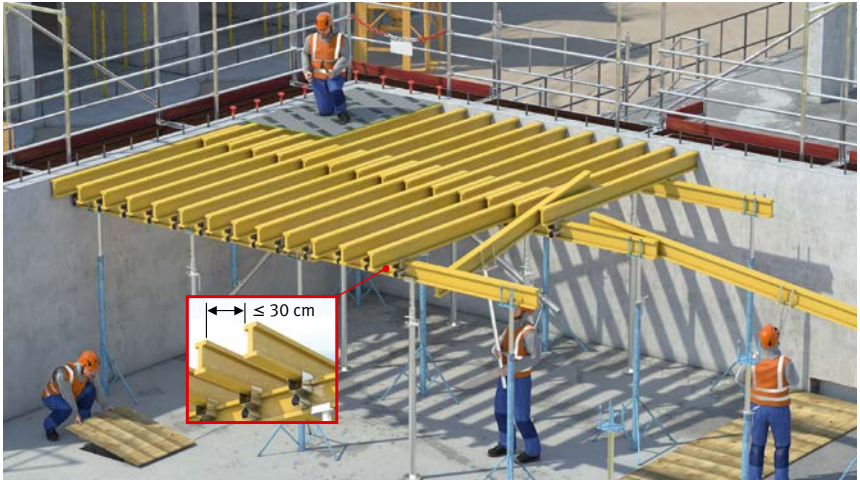
Abb. 9 Verlegen von Schalungsplatten von oben ohne Einsatz von PSAgA, lichter Querträgerabstand \leq 30\text{ cm} .
