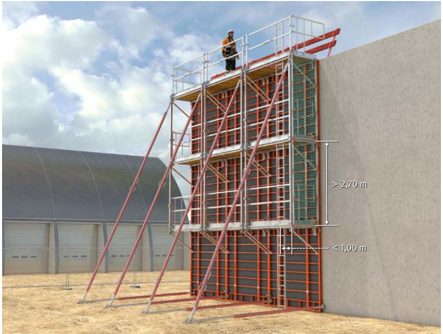
Abb. 3 Absturzsicherung und Zugang an einer Wandschalung
