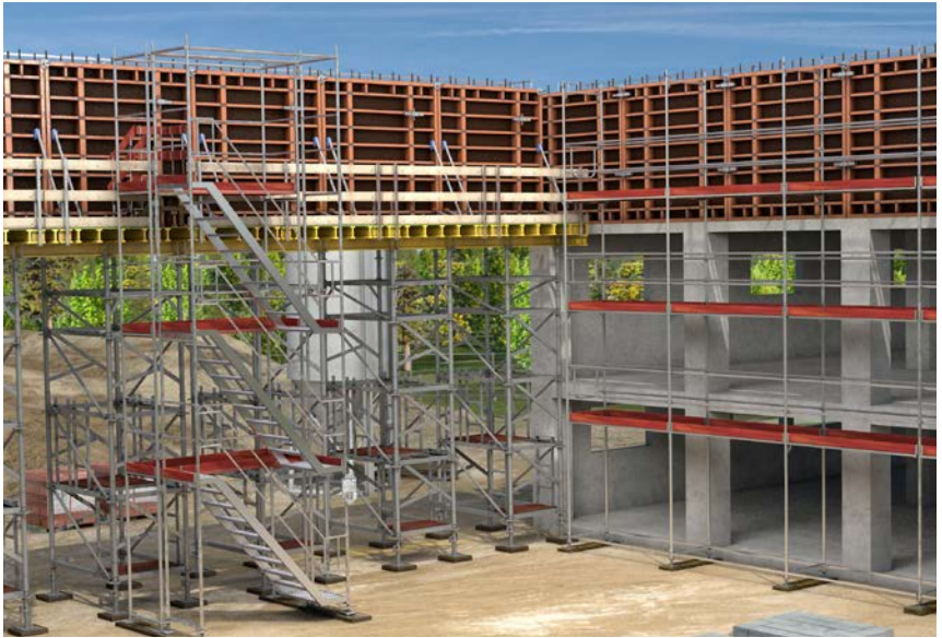
Abb. 12 Verkehrsweg an und auf Tragkonstruktion.
