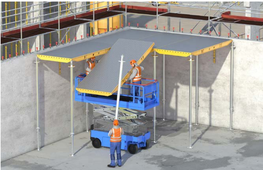
Abb. 6b Aufbau von Deckenschalungssystemen mittels Hubarbeitsbühne
