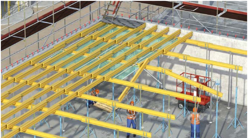
Abb. 10 Verlegen von Schalungsplatten von oben mit Schutznetzen (Sicherheitsnetzen), lichter Querträgerabstand > 30\text{ cm} .
