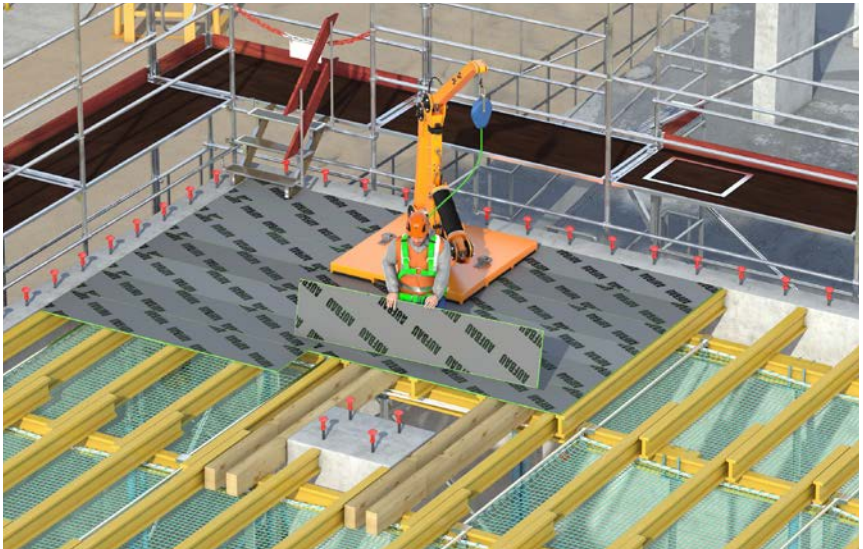
Abb. 11 Verlegen von Schalungsplatten von oben mit PSAgA an Störstellen.
