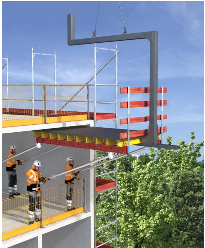
Abb. 8 Schaltisch mit integrier- tem Seitenschutz und klappbaren Stützelementen
