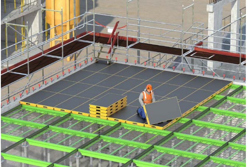
Abb. 6c Aufbau von Deckenschalungssystemen mittels eingelegten Gitterelementen
