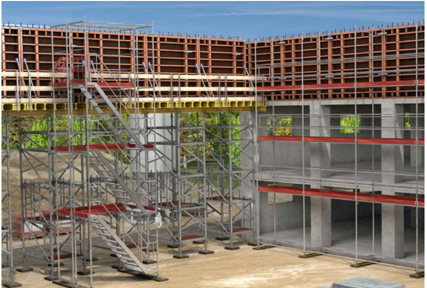
Abb. 12 Verkehrsweg an und auf Tragkonstruktion.
