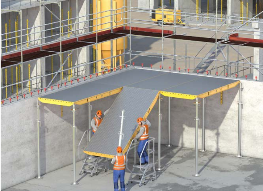
Abb. 6a Aufbau von Deckenschalungssystemen mittels Podesttreppe
