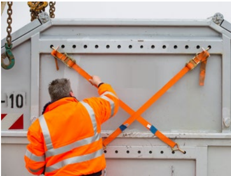
Abb. 35 Sicherung gestapelter Absetzbehälter durch X-Zurrung
