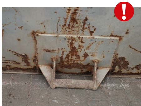
Abb. 17 Aufgeschweißtes Kip- plager entspricht nicht der DIN 30720-1
