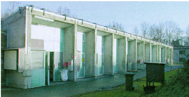
Abb. 11: Typisches Reihengebäude in Ausblasebauart mit schwerer Dachausführung
