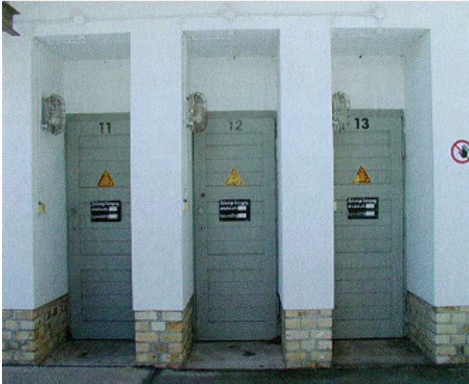
Abb. 10: Abstellgebäude für Sätze
