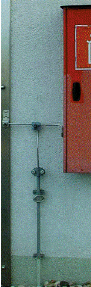
Abb. 14: Blitzschutz und Erdungsmaßnahmen an Gebäudeeinrichtungen
