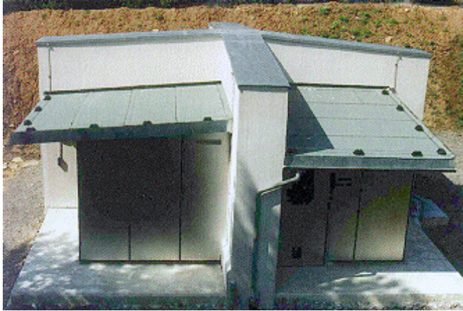
Abb. 9: Modernes Trockengebäude in Kreuzform (4 Räume in Ausblasebauart durch Widerstandswände getrennt)
