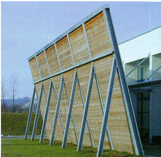
Abb. 12: Gebäude in Ausblasebauart mit wirksamen Splitterschutz
