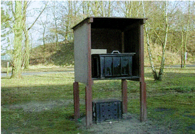
Abb. 18: Abstellbox für Satzabfälle und pyrotechnische Reststoffe außerhalb von Gebäuden
