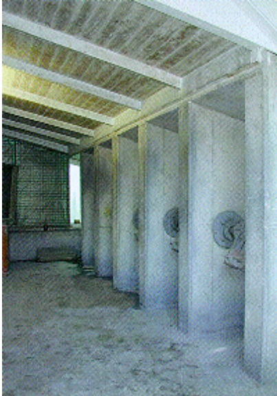
Abb. 23: Mischgebäude mit einzelnen Kojen
