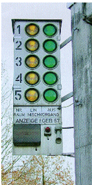
Abb. 22: Anzeigetafel für Räume in denen "unter Sicherheit" Mischeinrichtungen betrieben werden
