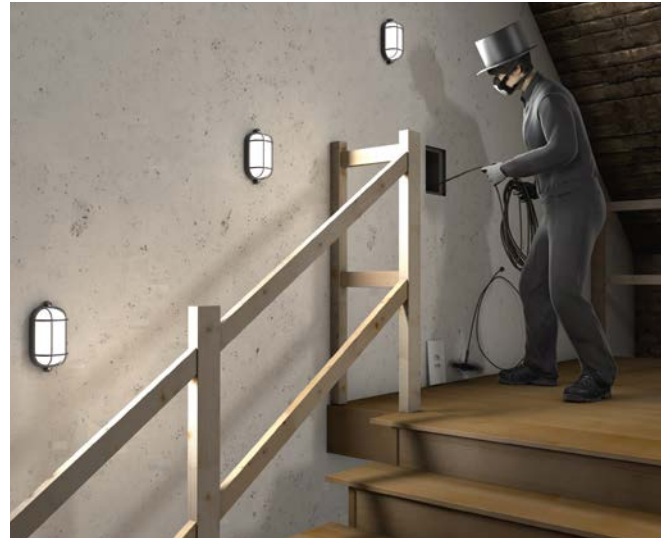
Abb. 15 Arbeitsplatz unter Dach mit Absturzsicherung
