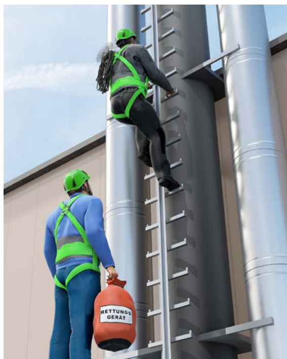
Abb. 26 Beispiel für eine Steigschutzeinrichtung
