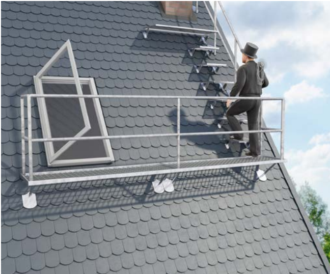
Abb. 14 Absturzsicherungen an der Traufe und dem Ortgang
