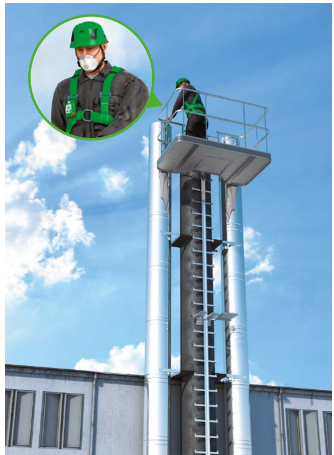
Abb. 17 CO- Warngerät am Arbeitsplatz
