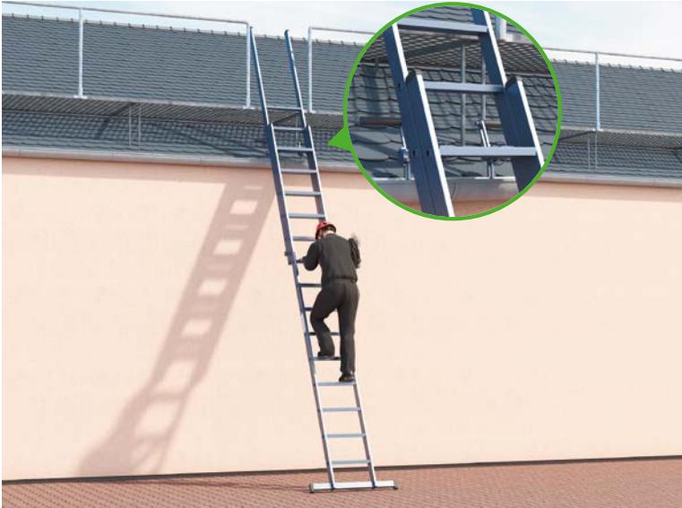
Abb. 11 Aufstieg mit gesicherter Anlegeleiter
