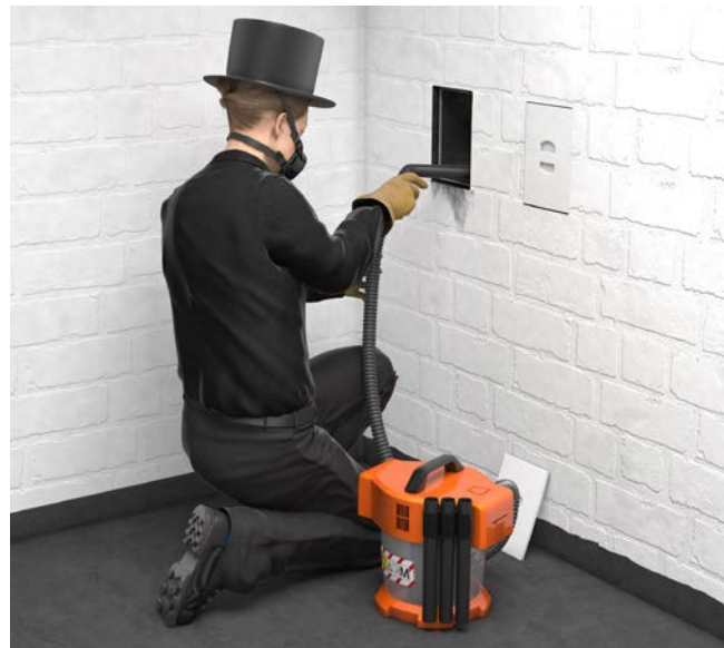
Abb. 22 Einsatz eines Entstaubers
