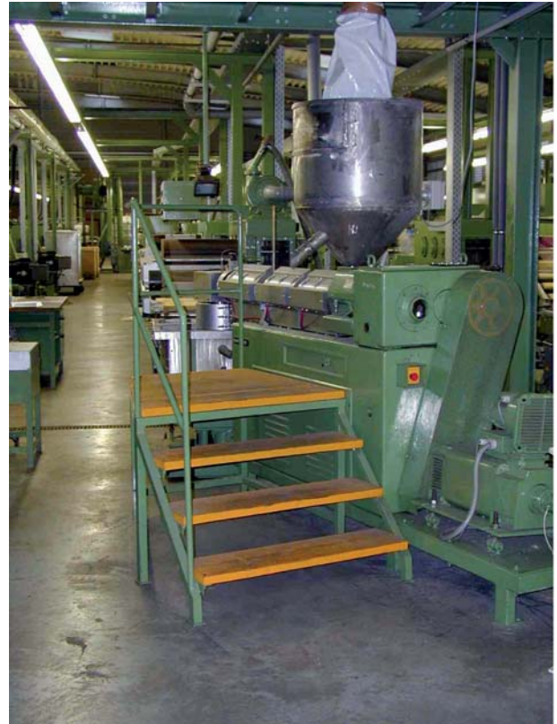
Abbildung 3: Arbeitsplattform an einem Extruder
