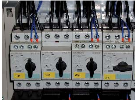
Abbildung 30: Fingersichere Anschlussklemmen
