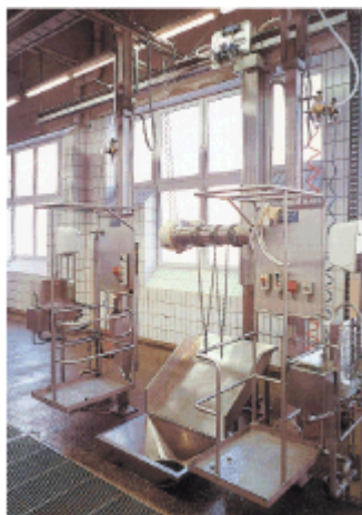
Bild 35: Enthäutepodest mit Absturzsicherungen
