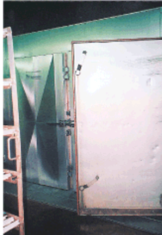
Bild 50: Rauchkammertür mit innenliegender Entriegelung
