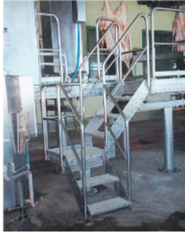
Bild 8: Zugang zum höhergelegenen Arbeitsplatz
