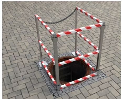
Abb. 12 Absturzsicherung an einem geöffneten Schacht
