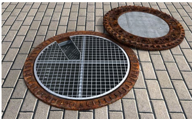
Abb. 13 Durch Abdeckkruste gesicherte Schacht- öffnung
