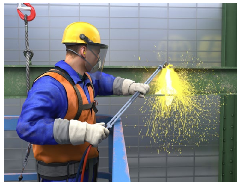
Abb. 56 Persönliche Schutzausrüstungen beim Brennschneiden
