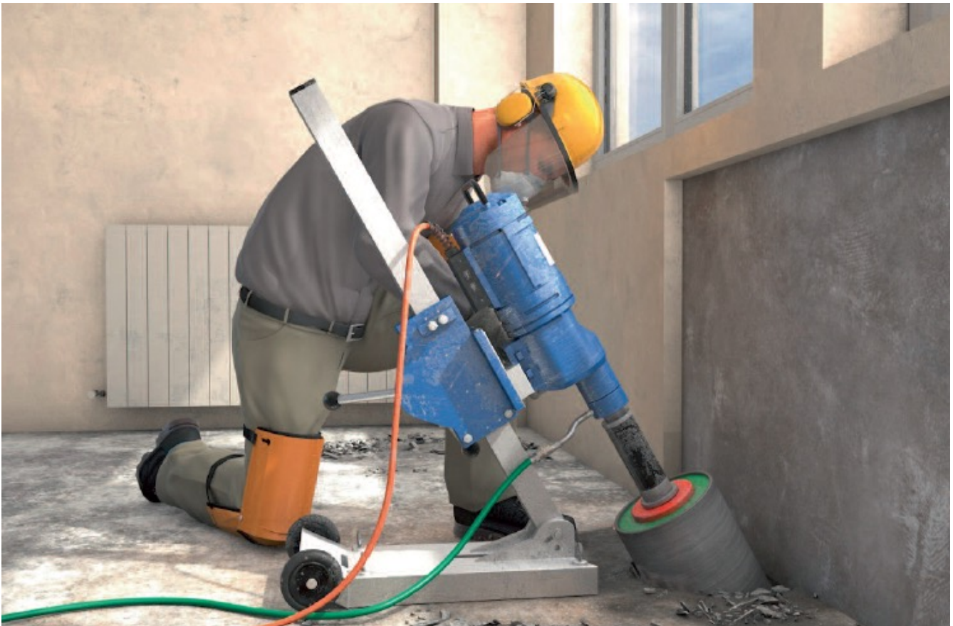
Abb. 40 PSA bei Betonbohrarbeiten
