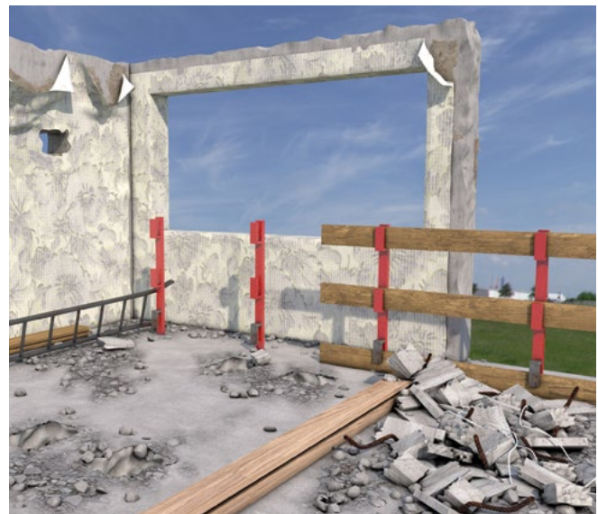
Abb. 111 Absturzsicherung vor der Demontage anbringen
