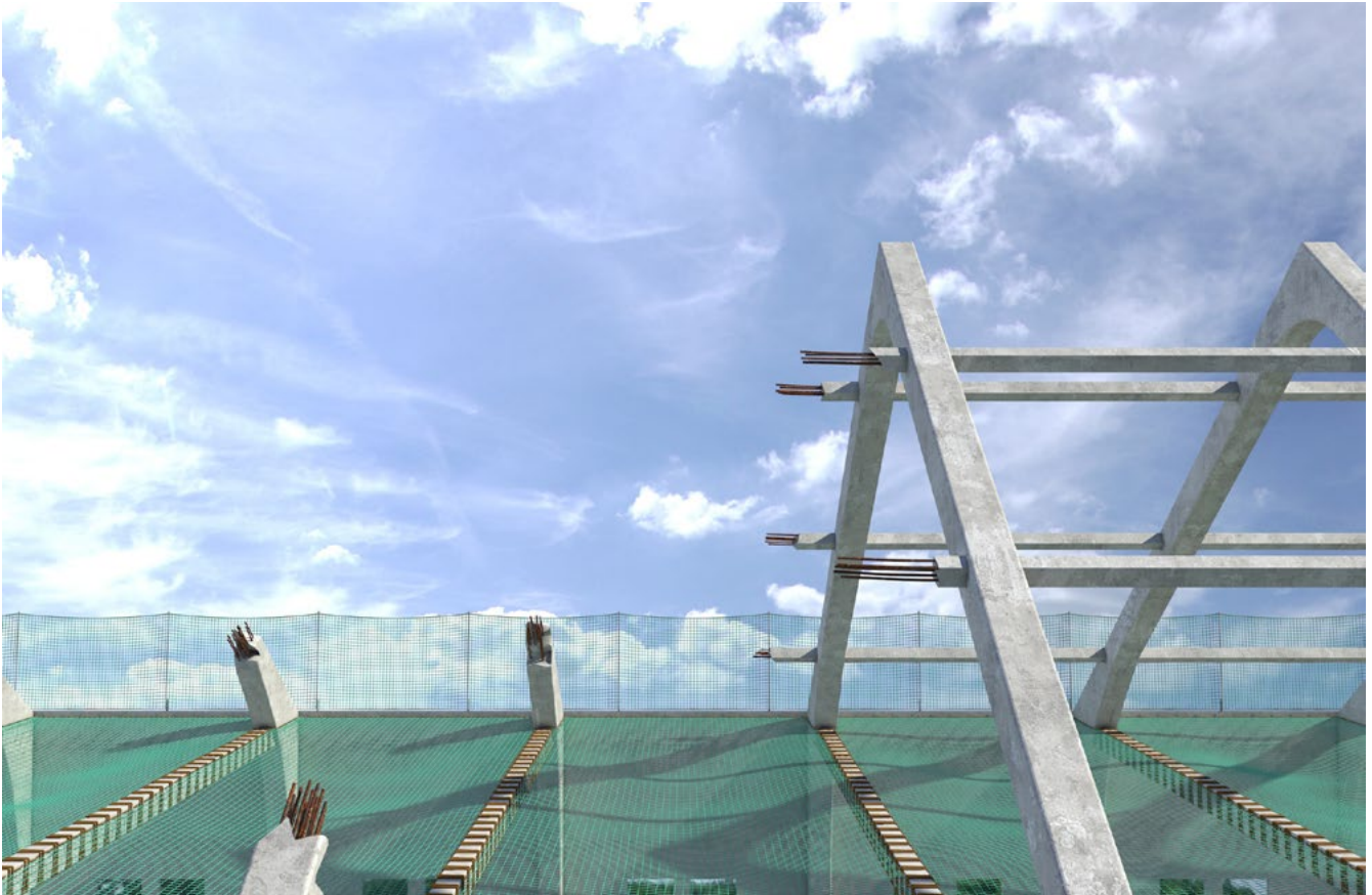
Abb. 5 Schutznetze und Randsicherung als Schutzmaßnahme beim Rückbau von Dachkonstruktionen
