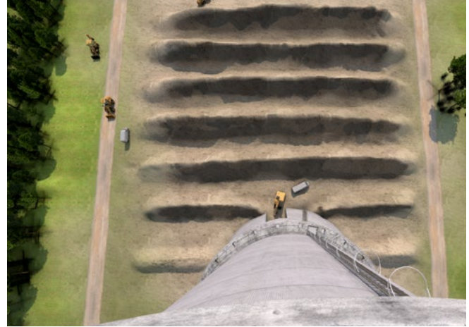
Abb. 119 Fallbett für eine Schornsteinsprengung
