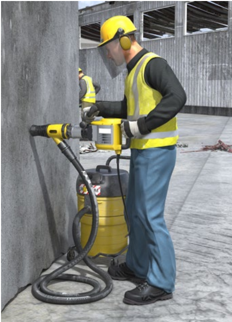
Abb 26 Persönliche Schutzausrüstung bei Arbeiten mit dem Bohrhammer
