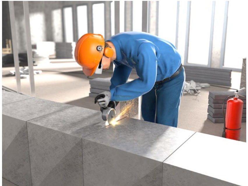
Abb 27 Persönliche Schutzausrüstung beim Trennschleifen von Metall
