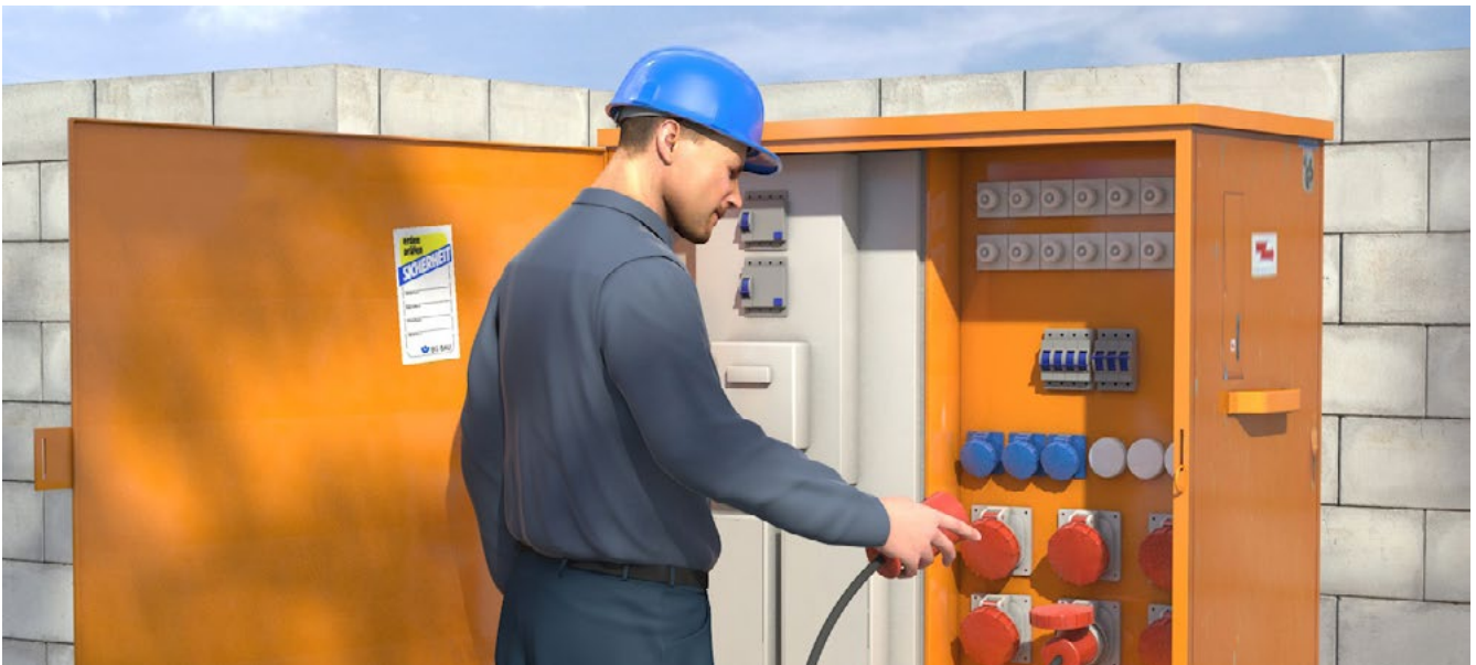
Abb. 20 Baustromverteiler zur sicheren Stromversorgung einer Baustelle
