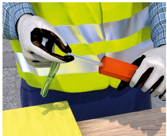
Abb. 120 Herstellen einer Initialladung
