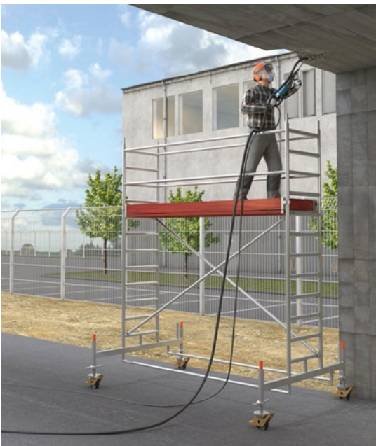
Abb. 99 Manuelle Abbrucharbeiten
