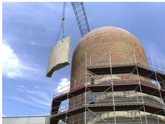
Abb. 109 Rückbau einer Gebäudehülle
