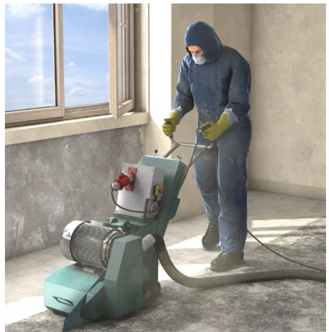
Abb. 16 Abschleifen PAK-haltiger Kleber
