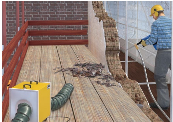
Abb. 4 Absturzsicherung durch Seitenschutz bzw. durch Fassadengerüst
