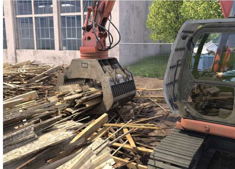
Abb. 124 Sortiergreifer
