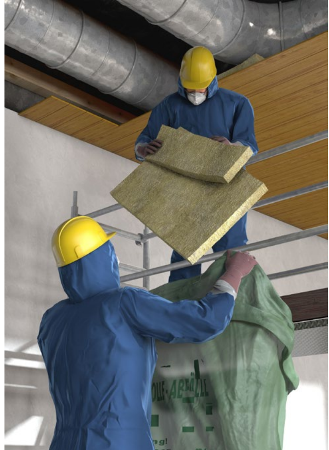
Abb. 11 Ausbau von Dämmplatten
