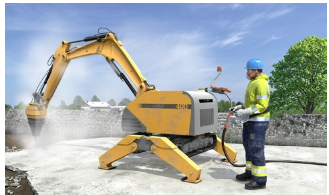
Abb. 102 ferngesteuerte Abbruchmaschine statt handgeführte Werkzeuge
