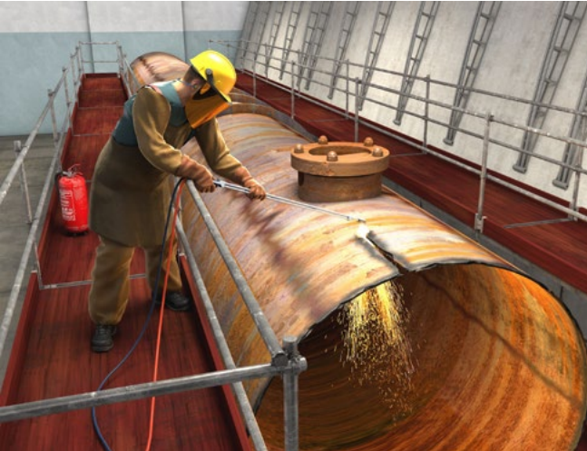
Abb. 114 Rückbau Rohranlage
