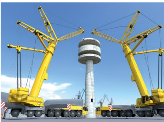
Abb. 108 Demontage eines Turms aus Stahlbeton
