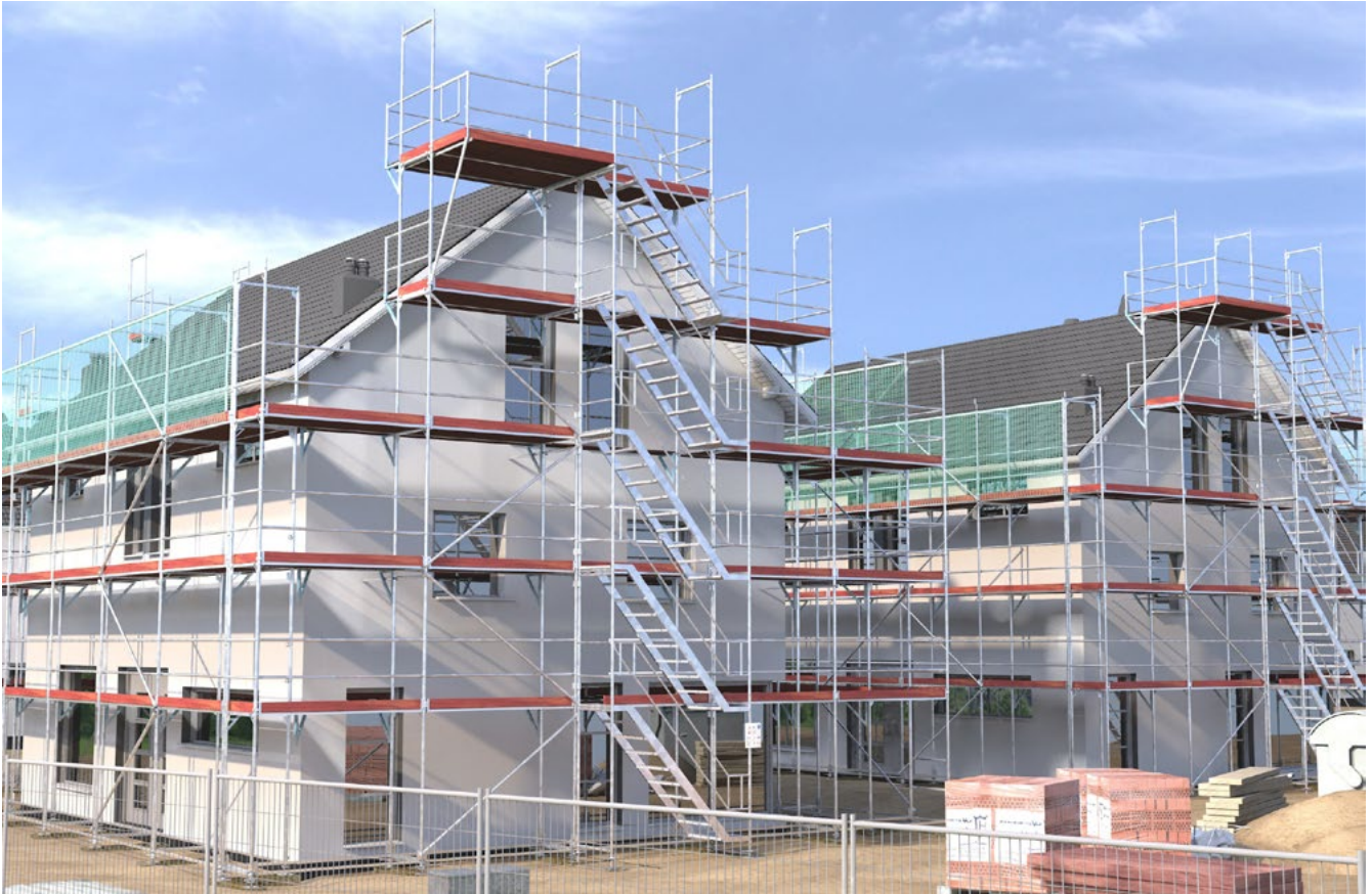
Abb. 53 fachgerechter Zugang zum Gerüst
