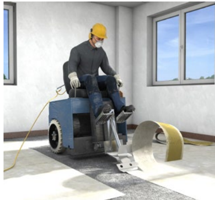
Abb. 90 Ausbau Fußbodenbelag
