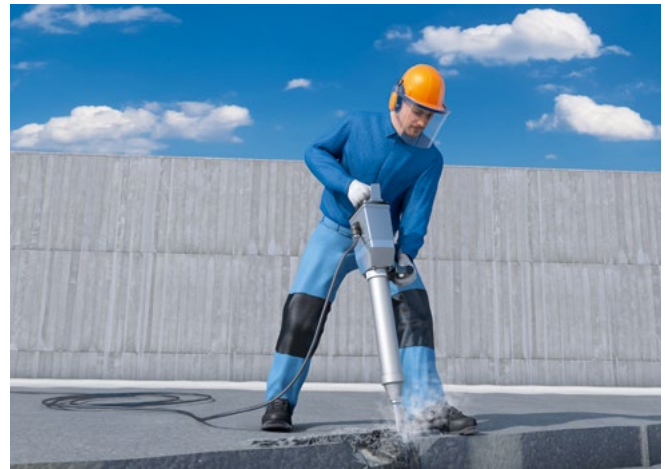
Abb. 39 Abbrucharbeiten mit geeigneter PSA
