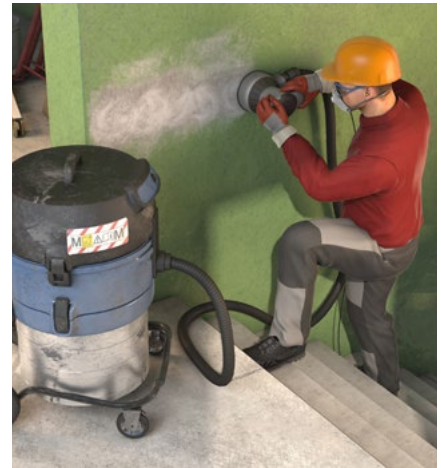
Abb. 10 Bau-Entstauber (z. B. Filterklasse M)
