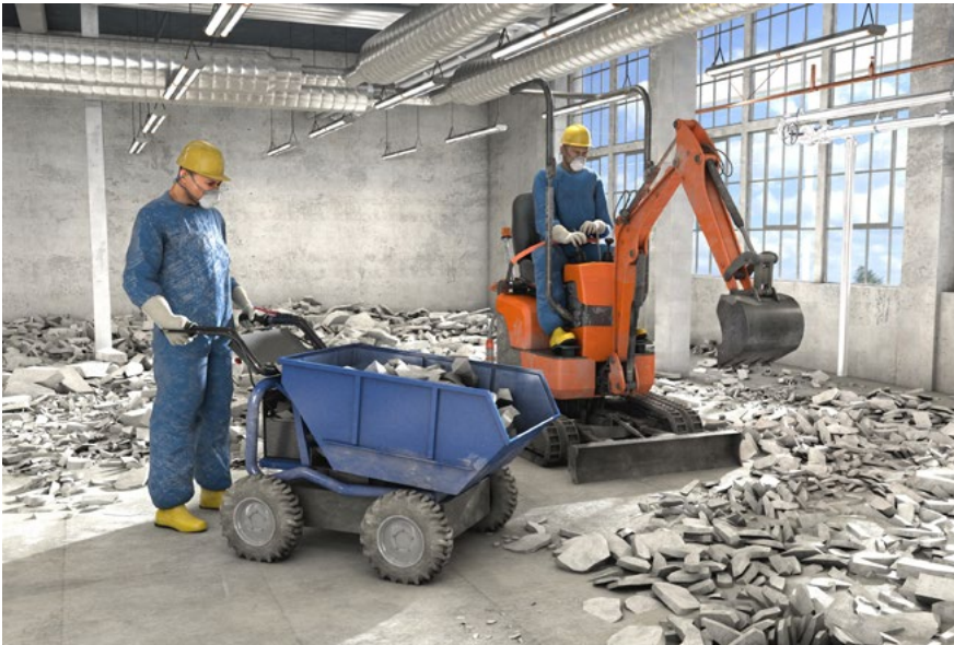
Abb. 92 Beräumung von Schutt
