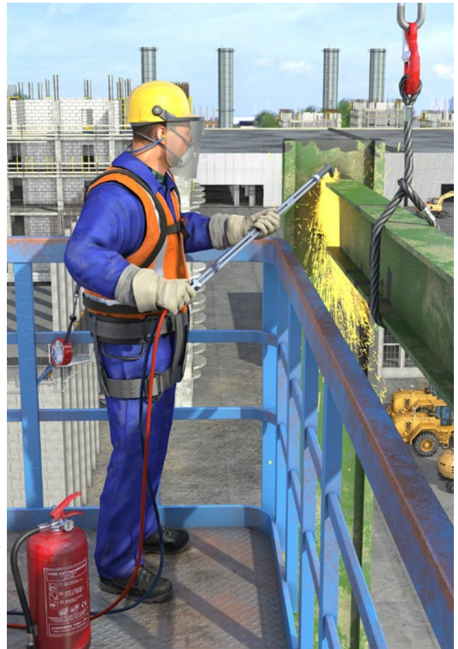
Abb. 25 Schneidbrennarbeiten
