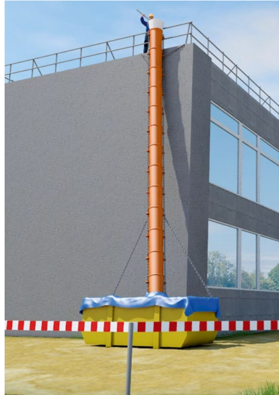
Abb. 103 Absturzsicherung an Schuttrutsche
