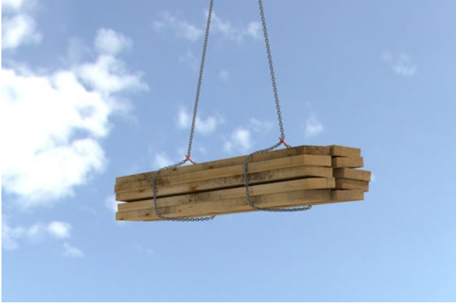
Abb. 79 Kettengehänge im Schnürgang
