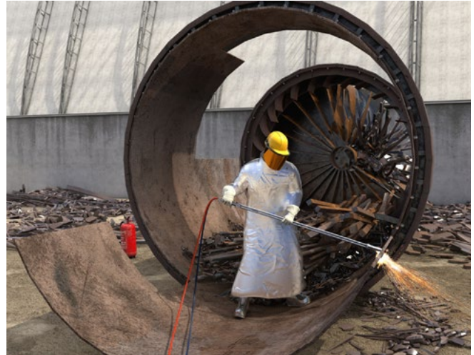
Abb. 115 Brennschneidarbeiten
