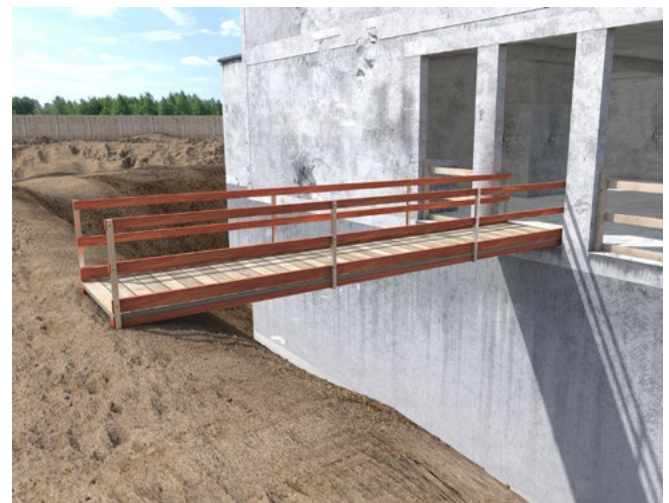
Abb. 6 Laufsteg mit Seitenschutz als Verkehrsweg
