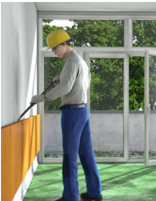
Abb. 89 Ausbau Wandverkleidung
