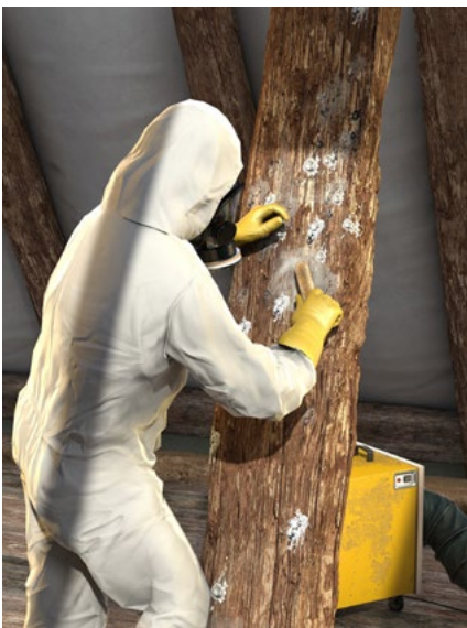
Abb. 13 Sanierung eines holzschutzmittelbelasteten Dachstuhls
