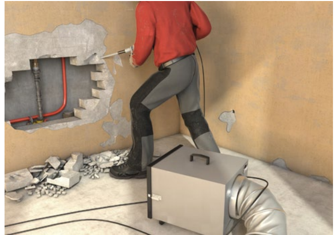
Abb. 12 Luftreiniger bei Stemmarbeiten
