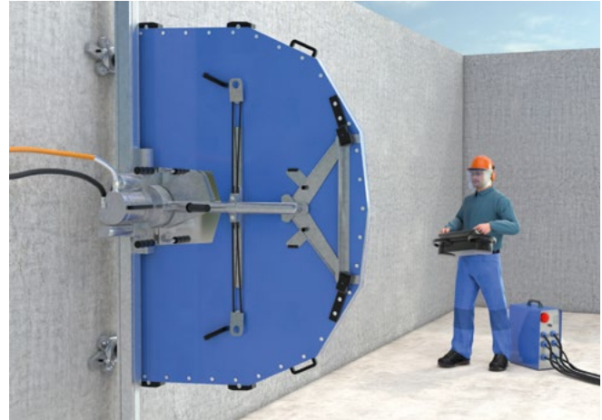
Abb. 105 Betonsägearbeiten
