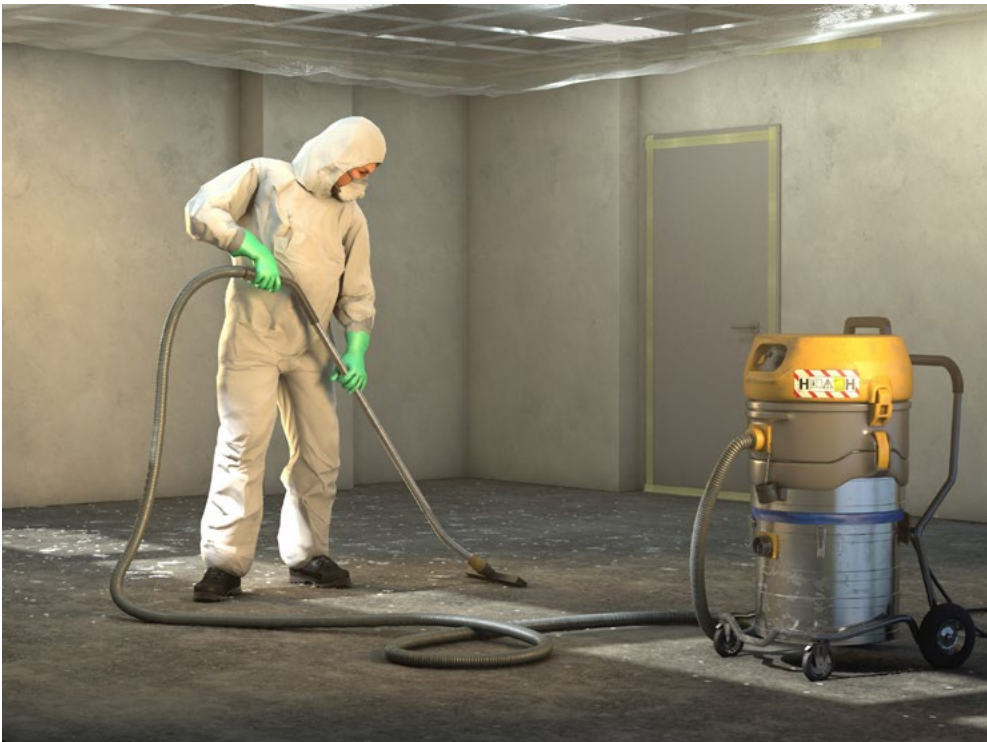
Abb. 19 Industriestaubsauger Staub- klasse H zur Reinigung einsetzen
