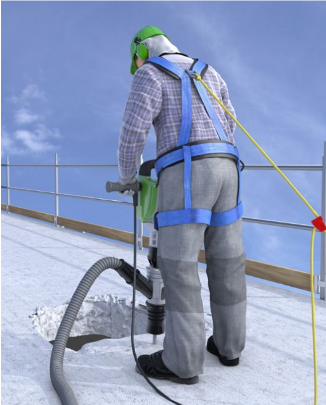
Abb. 101 Abbrucharbeiten mit PSAgA
